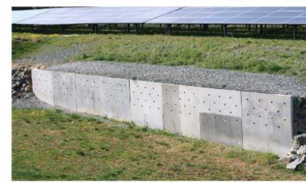
Mesure d'accompagnement pour la faune : aménagement pour la nidification des hirondelles sur la centrale photovoltaïque de la Petite-Vicomté aux Ponts-de-Cé.
