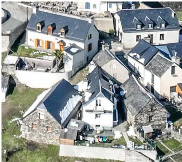
Vue depuis le sud : grange B (à gauche) et grange C (à droite)
