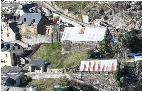
Grange G : vue depuis l'ouest
