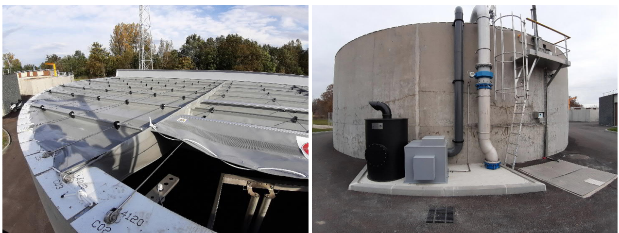
Exemple de couverture sur silo à boues et son unité de désodorisation
