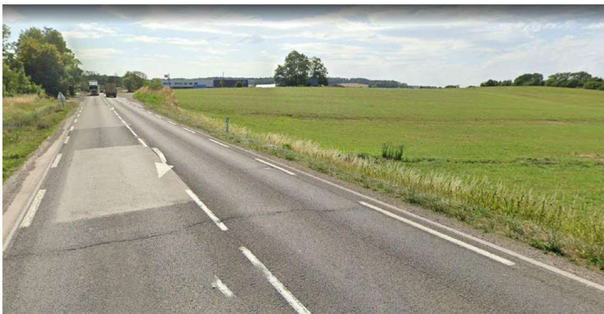
Vues du site depuis la RN 19 à l'Est. La ligne de crête masque partiellement le bâtiment existant.
