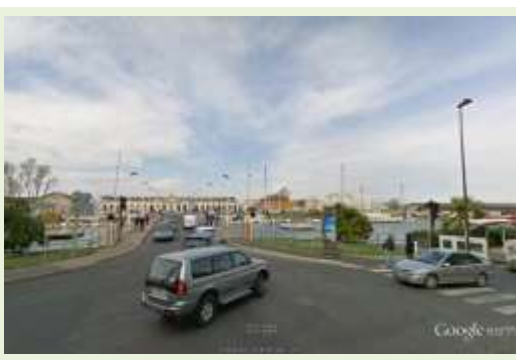
Ouvrage routier dédié aux automobiles. Les cyclistes circulent dans le trafic automobile.
