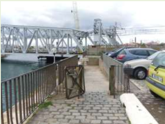
Passage sous la voie ferrée pour accéder à pointe courte
