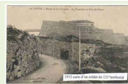
La trouée du théâtre de la mer ; un espace public emprunté par le tramway et les piétons
