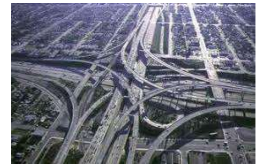
Un échangeur autoroutier
