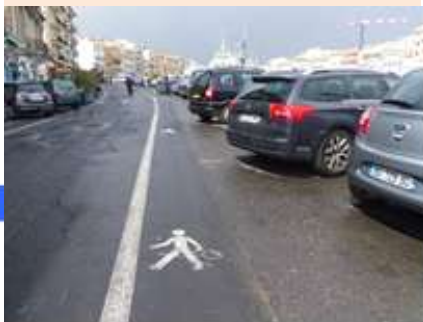
aménagement actuel ; les piétons circulent sur la chaussée
