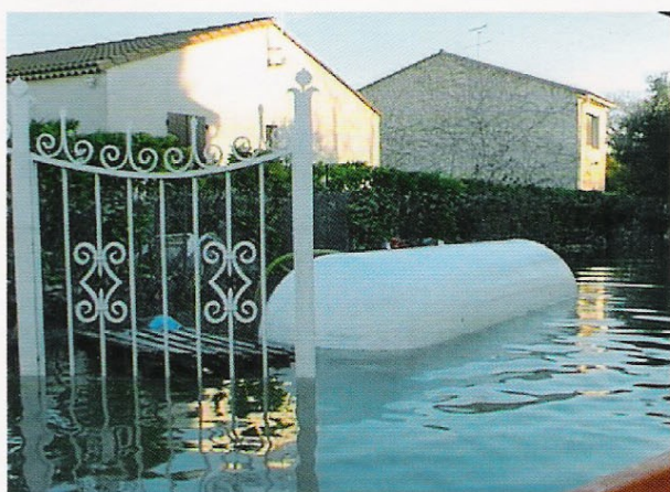
Cuve soulevée par l'eau.
