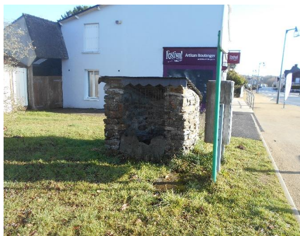
Puits centre bourg
