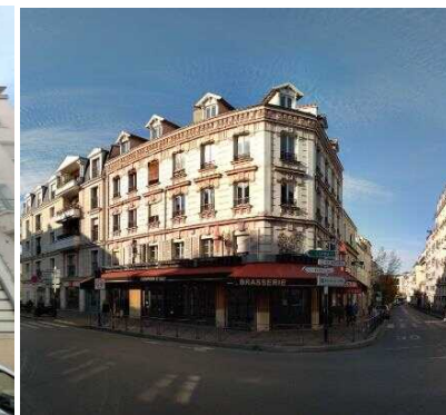
Rue du général Leclerc, Issy-les- Moulineaux
