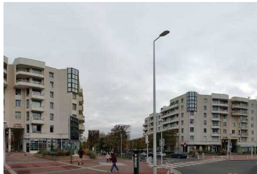
Figure 25 : Formes urbaines denses aux abords du pont de Billancourt – Source : GPSO
