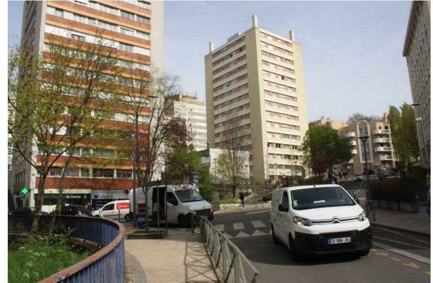
Figure 15 : Tissu urbain dense constitué de grands ensembles le long de la RD910, à Sèvres – Source : Citadia
