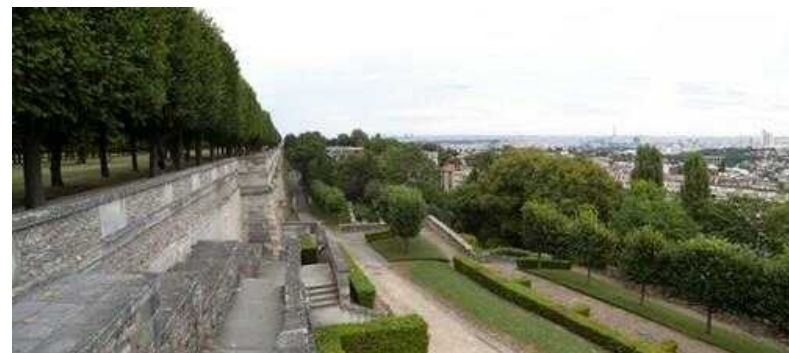
Figure 30 : Terrasses du château de Meudon – Source : Citadia
