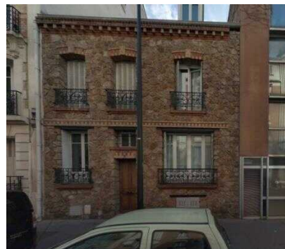
Rue du château, Boulogne-Billancourt
