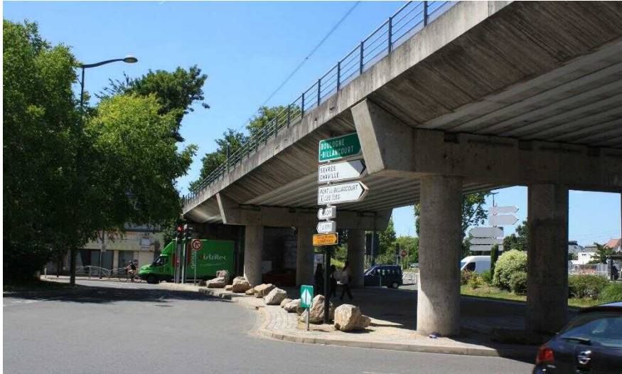
Figure 69 : Traversée du tramway à Issy-les-Moulineaux – Source : Citadia
