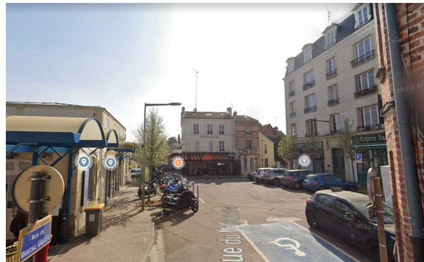
Figure 103 : Entrée de ville depuis la gare de Sèvres-Ville d'Avray - Source : Google Street View
