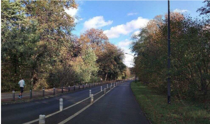
Figure 14 : Passage de la RD985 dans la forêt de Fausses-Reposes – Source : GPSO
