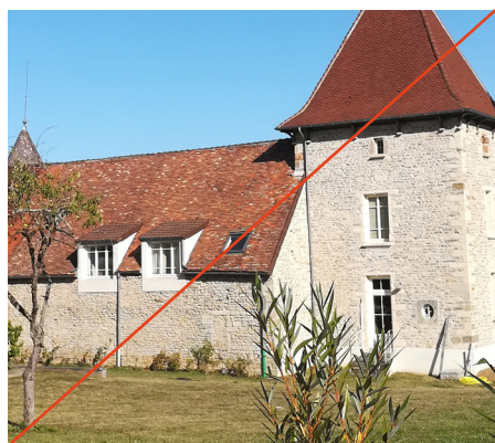
Lucarnes rampantes et fenêtre de toit (Cheilly-lès Maranges)
