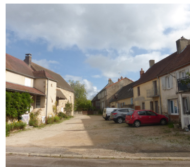
Bâtiments d'habitation organisés autour d'une cour trapézoïdale.
