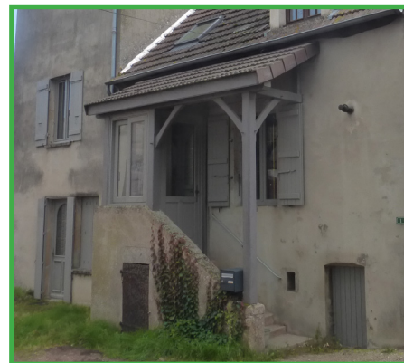
Fermeture du auvent par des menuiseries de même type et de teinte identique.
