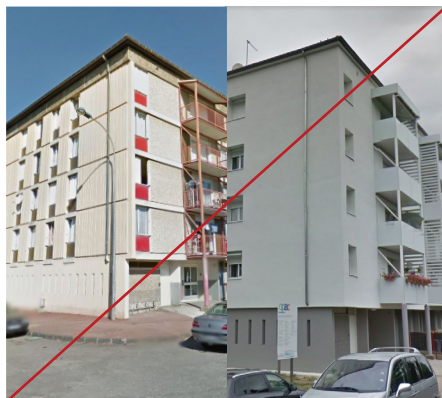
Isolation par l'extérieur : immeuble aseptisé qui a perdu son identité architecturale.
