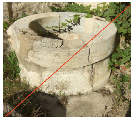
Reprise en ciment, disparition du portique (Demigny)
