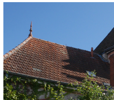
Tuiles plates rectangulaires mécaniques à emboîtement, côte losangée, terre cuite.
