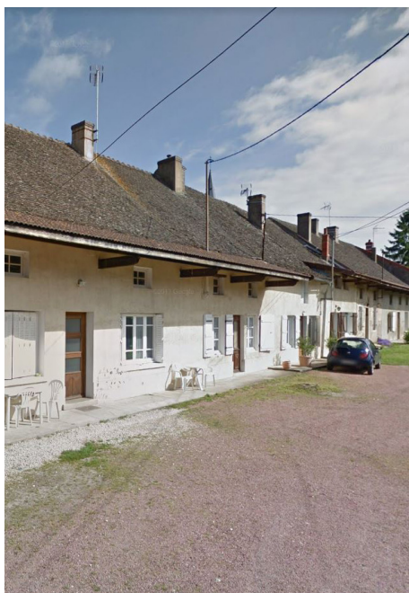
Corps de ferme avec débord de toit important (Marnay)
