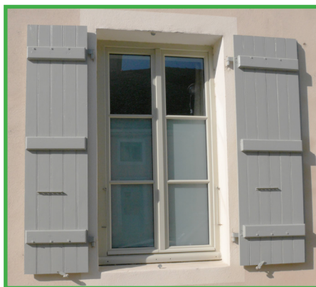
Fenêtre neuve en bois à double vitrage ayant conservé son dessin d'origine à grands carreaux.
