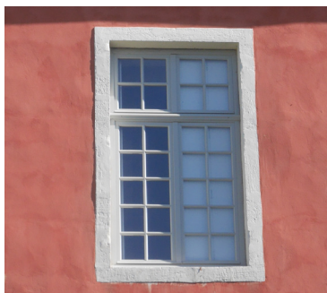
Menuiserie à petits carreaux et traverse moulurée, XVIII e siècle.
