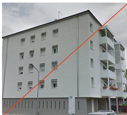
Isolation par l'extérieur, façade banalisée (Prés St-Jean, Chalon)
