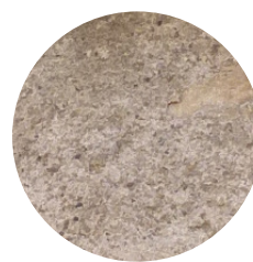
Enduit à la chaux naturelle
