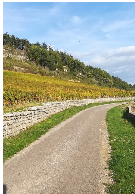
Muret en pierre sèche (Mercurey)
