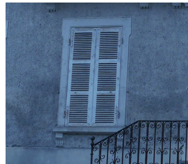
Contrevent à deux vantaux, compartiments persiennés.
