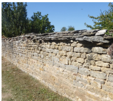
Mur en moellons avec couronnement en lave calcaire.
