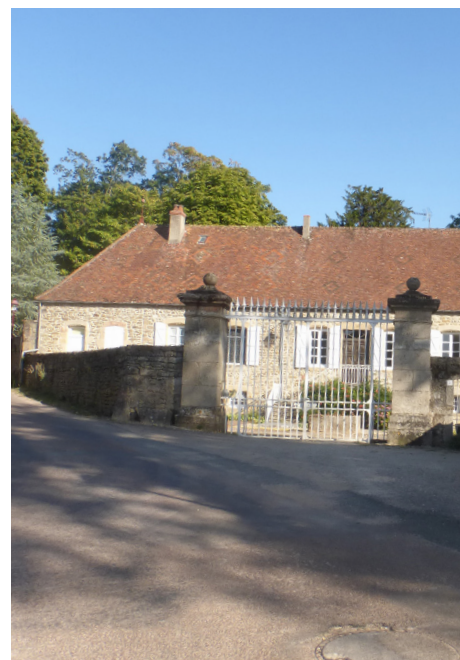
Toiture à quatre pans très marquée (Saint-Sernin-du-Plain)
