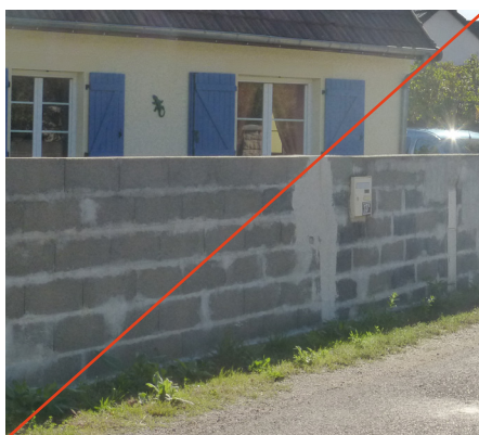
Mur de clôture haut non enduit (Sassenay)
