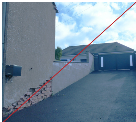
Voie bitumée jusqu'en pied de façade.
