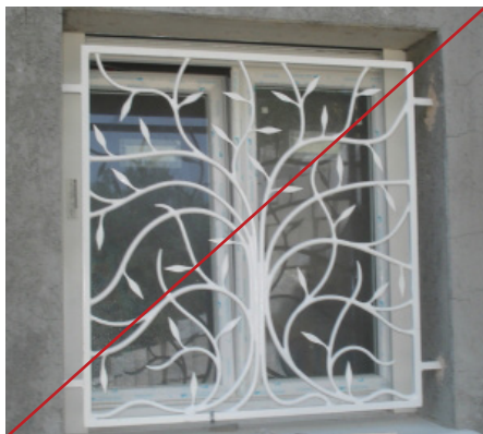
Grille de fenêtre très 'bavarde' et sans rapport avec le contexte local.
