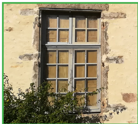
Fenêtre neuve en bois à double vitrage ayant conservé son dessin d'origine à petits carreaux.
