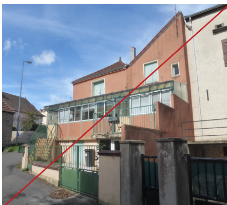
L'ajout de constructions successives ne permet plus de conserver une lisibilité aisée de la façade.
