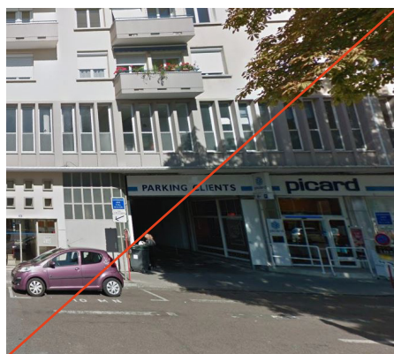
Enseignes et mobilier urbain mal intégrés à l'architecture (Chalon-sur-Saône)
