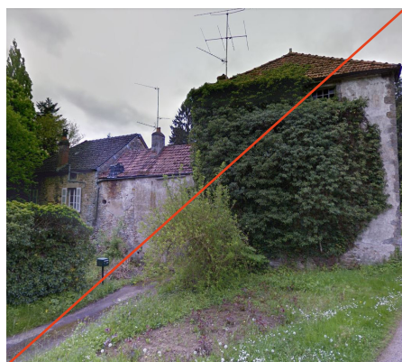
Moulin envahi par la végétation (Sampigny-lès-Maranges)
