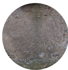
Enduit à la chaux naturelle
