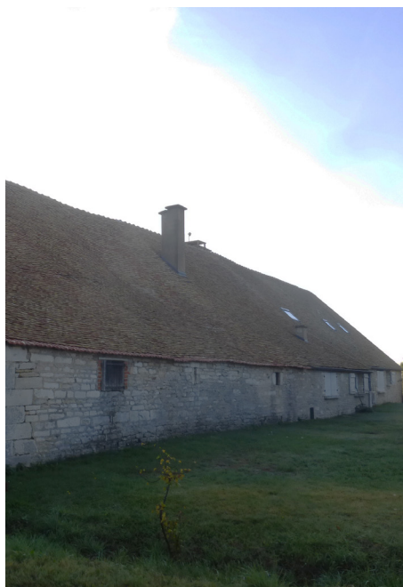
Ferme avec volume de toiture important (Saint-Loup-Géanges)
