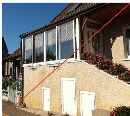
Fermeture de la galerie et changement des menuiseries (Saint-Gilles)
