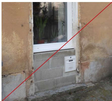
Enduire la maçonnerie des allèges créées et restituer un appui de fenêtre sur les modèles existants.
