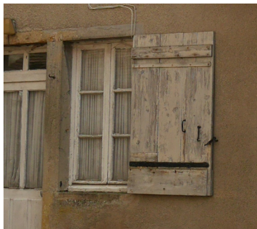
Contrevent plein à lames larges verticales irrégulières, quincaillerie en métal.
