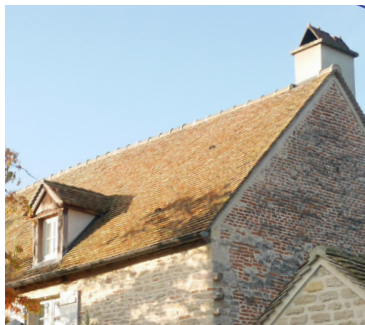
Lucarne en bois à deux pans, souche enduite avec couverture de tuiles en bâtière.
