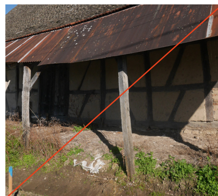
Débord de toit couvert en tôle (Lans)
