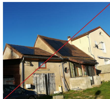
Les extensions et modification de pente peuvent complexifier lourdement une construction existante.
