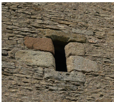
Encadrement en granit à chanfrein, bâtiment agricole.
