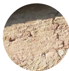
Enduit à la chaux naturelle
