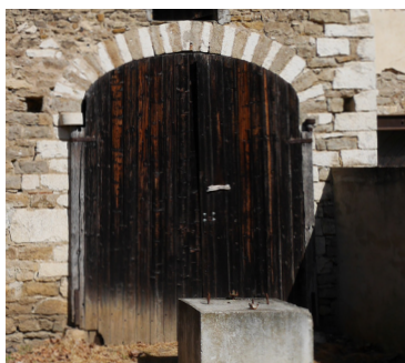
Porte de grange en bois reposant sur des gonds extérieurs en pierre.
