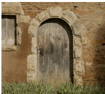
Porte en bois à lames verticales irrégulières.
