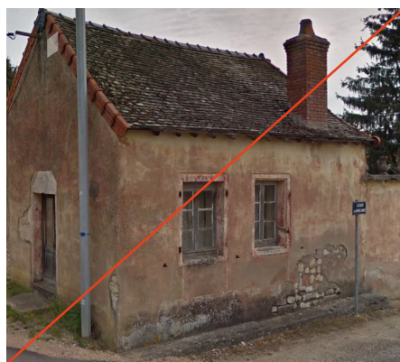
Chapelle de Corcassey transformée en habitation (Chatenoy-le-Royal)
