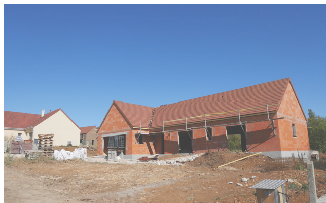
Construction d'une maison individuelle, hameau de Nantoux.
