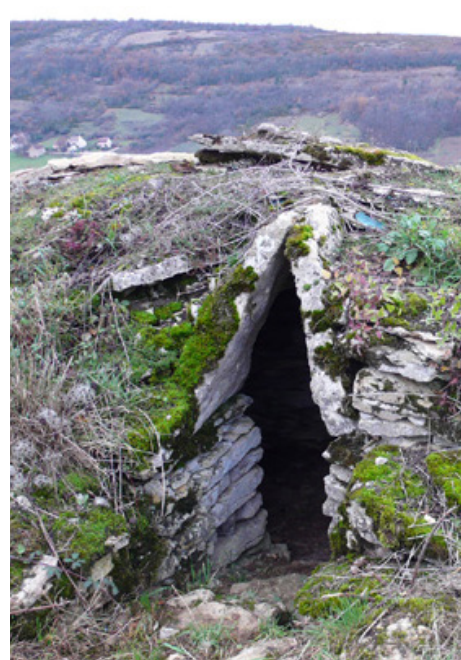
Entrée de cadole déchargée par une des pierres en bâtière (Chassey-le-Camp)
