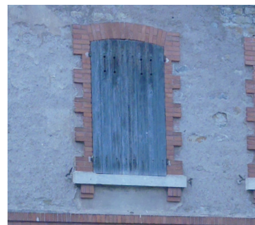
Encadrement en briques à chainage harpé, appui en pierre saillant sur consoles.
