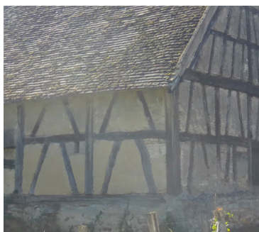
Pans de bois, remplissage en briques, finition à l'enduit.
