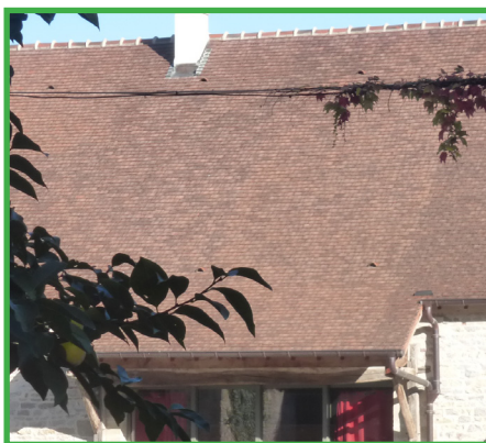
Couverture en tuiles plates avec arêtier en tuiles canal et arrêts en forme d'anneau.
