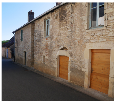
Percements aléatoires directement liés aux usages intérieurs.
