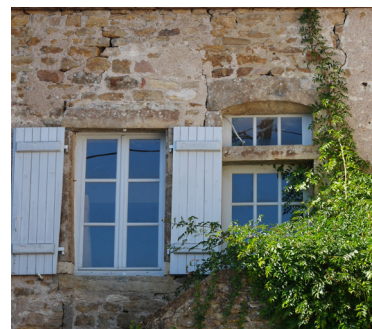
Encadrements en pierre, linteau de porte à délardement circulaire.
