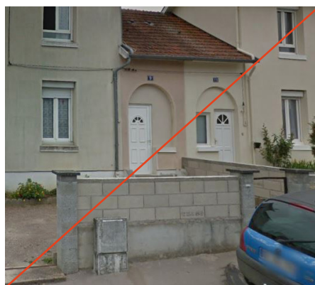
Remplacement clôture en maçonnerie et log- gia murée (Charreaux, Chalon-sur-Saône)
