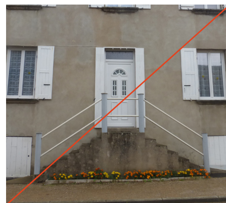
Porte d'entrée et garde-corps standardisés (Saint-Léger-sur-Dheune)
