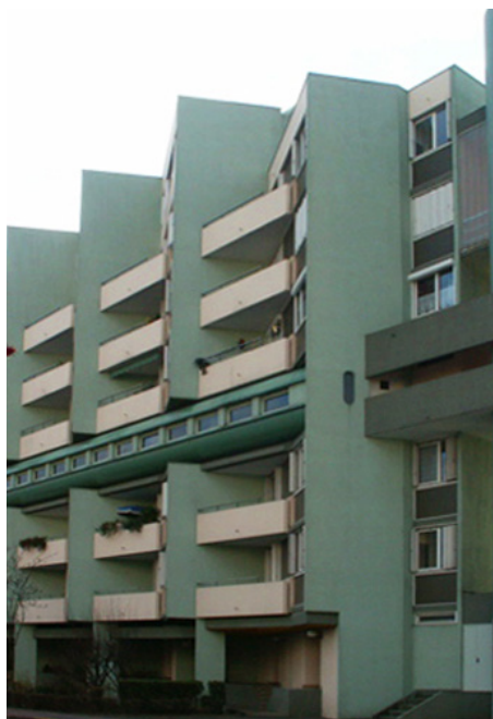
Façade sur rue de l'immeuble La Frégate (Chalon-sur-Saône)
