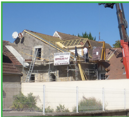
Profiter de la réfection d'une toiture pour isoler les combles.
