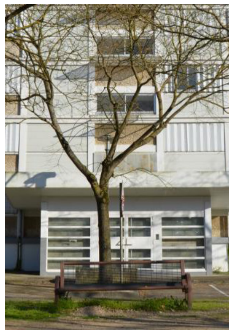
Entrée d'immeuble des Aubépins (Chalon-sur-Saône)
