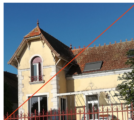
Remplacement des lucarnes par des fenêtres de toit (St-Gilles)
