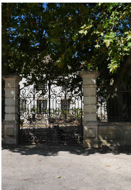
Entrée de manoir : piles à bossage et portail ouvragé (Cheilly-lès-Maranges)
