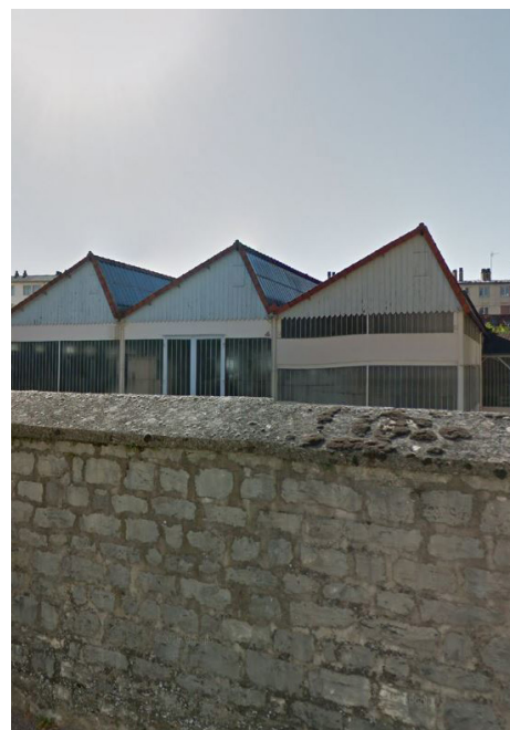
Toiture en sheds dans le quartier Garibaldi (Chalon-sur-Saône)
