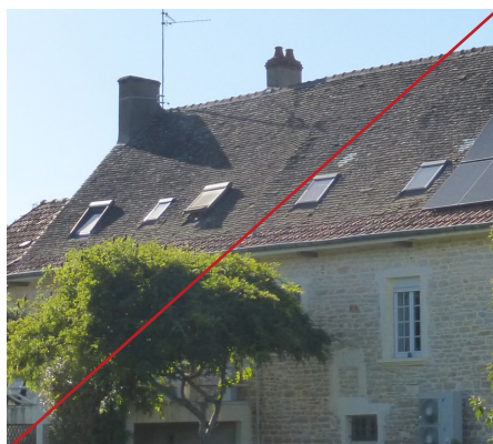
Multiplication des tailles et dispositions de châssis de toit.
