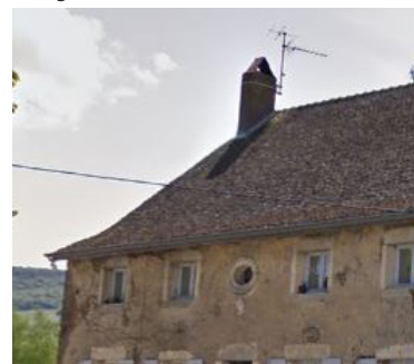
Toiture à quatre pans avec coyau et léger débord.
