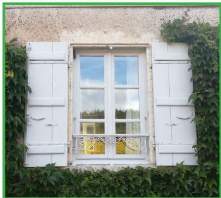
Réfection à l'identique de contrevents pleins à lames irrégulières; quincaillerie en conservation.
