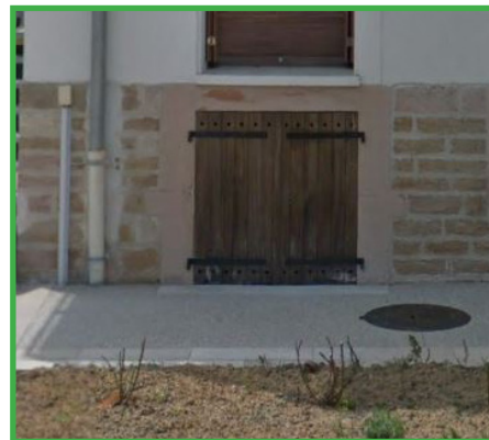
Intégration discrète des éléments techniques derrière des contrevents en bois.
