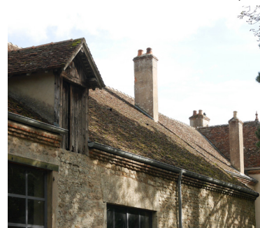
Lucarne passante en bois, corniche en briques, souches enduites.
