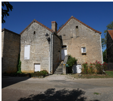
Pignons donnant sur la rue.
