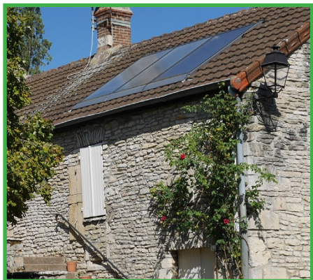
Panneaux discrets et intégrés à l'arrière de la toiture.
