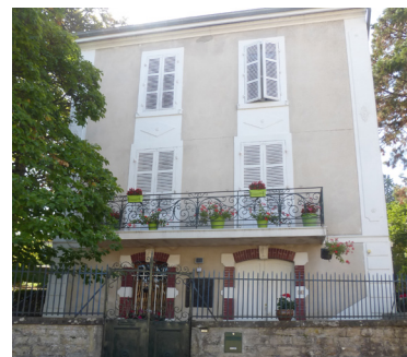
Alignement strict des baies, hiérarchie des encadrements.
