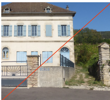
Modification des clôtures (Saint-Bérain-sur-Dheune)
