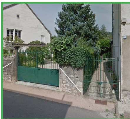
Portail et portillon métalliques simples.
