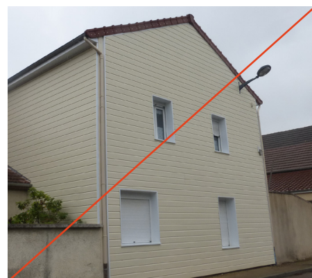
Isolation par l'extérieur (Saint-Léger-sur-Dheune)
