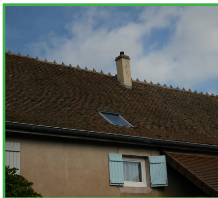
Châssis de toit isolé et aligné à la trame des ouvertures en façade.
