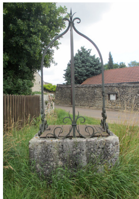
Puits à portique en fer forgé (Rully)
