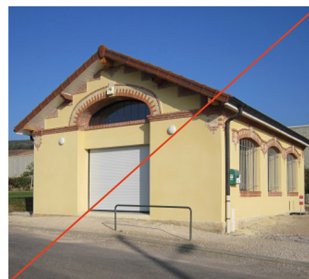
Transformation du lavoir en 'club house' (Saint-Désert)
