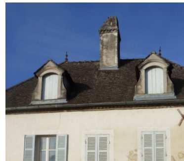
Lucarnes en pierre à fronton et volutes, souche carrée enduite avec couronnement en briques.
