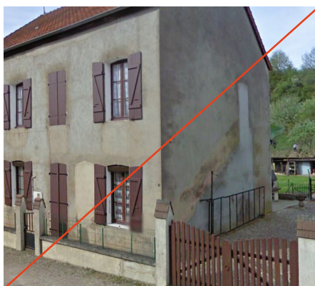
Suppression de l'escalier latéral (Saint-Sernin-du-Plain)
