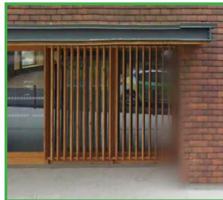
Brise-vue à claire-voie en lames de bois toute hauteur sur une construction neuve.
