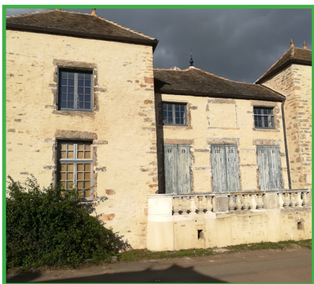
Enduit traditionnel à pierres vues à la chaux naturelle.
