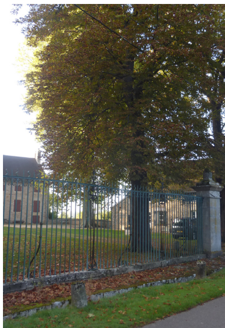
Composition en 'U' avec logis en fond de cours (Remigny)
