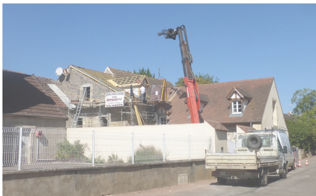
Rénovation d'une maison de bourg, Cheilly-lès-Maranges.
