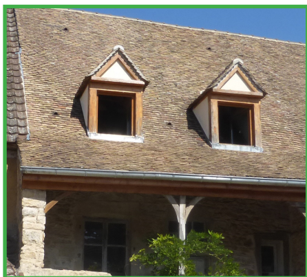
Lucarnes modernes à deux pans sur une toiture ancienne.
