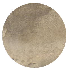
Enduit à la chaux naturelle
