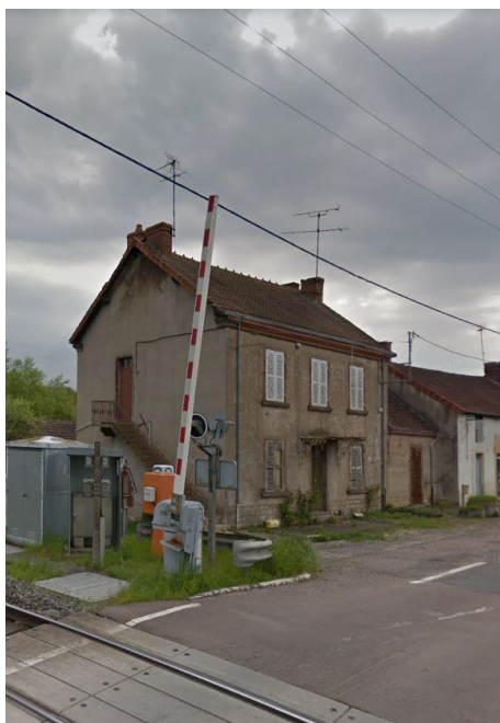
Maison de passage à niveau (Saint-Bérain-sur-Dheune)
