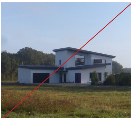
Toiture complexe de plans variables à faible pente qui jure dans le paysage.
