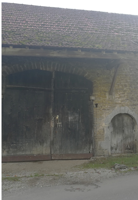
Entrée de grange avec auvent, portes en bois et gonds en pierre (Chamilly)
