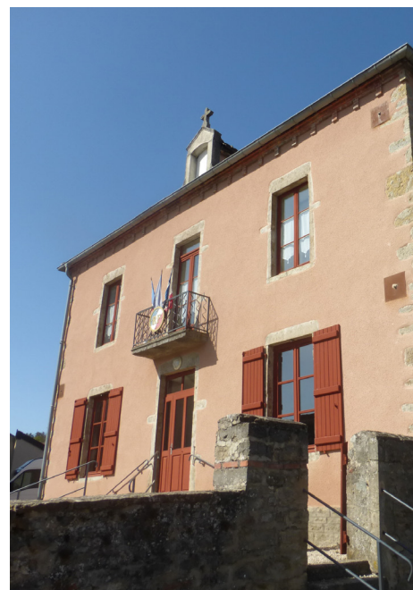
Ancien presbytère, lucarne surmontée d'une croix (Sampigny-lès-Maranges)
