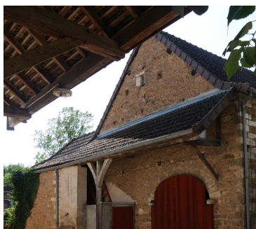
Auvent de protection d'une entrée de grange.
