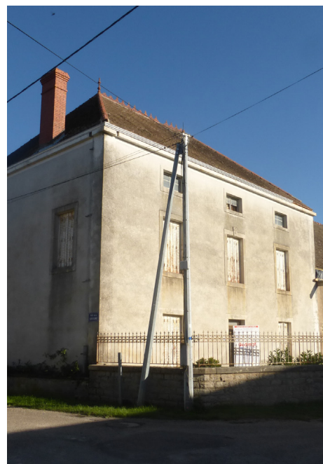
Maison avec souche de cheminée en brique et crête de faîtage (Virey-le-Grand)
