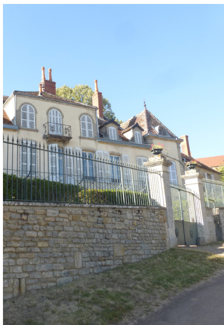
Maison bourgeoise avec pavillons latéraux (St-Sernin-du-Plain)
