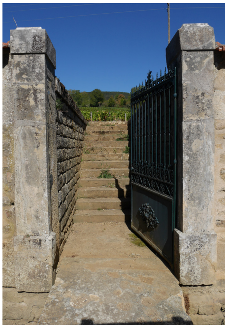
Entrée de clos (Sampigny-lès-Maranges)
