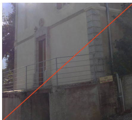
Garde-corps standardisé (Charrency)
