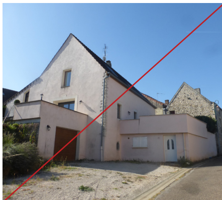
Garage et terrasse accolés peu subtilement au bâti existant et créant un rapport à la rue peu qualitatif.
