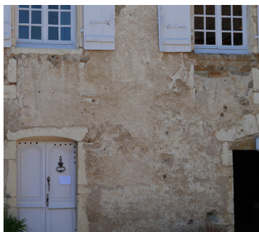
Enduit couvrant clair à la chaux naturelle.
