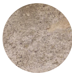
Enduit à la chaux naturelle
