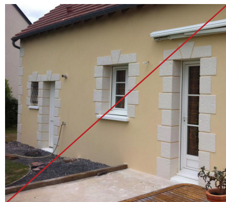
Le pastiche d'éléments d'architecture anciens est à éviter.
