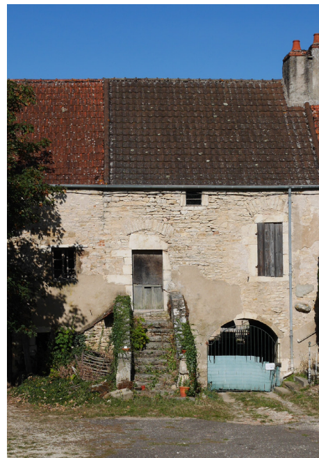
Maison à escalier droit perpendiculaire à la façade (Bouzeron)
