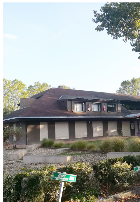
Mairie construite des années 60 (Mercurey)
