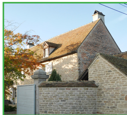
Réfection de couverture respectueuse des pentes et mises en oeuvres locales.
