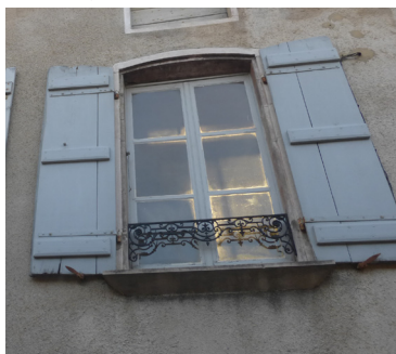
Menuiserie à grands carreaux, découpage au tiers, début XIX e siècle.
