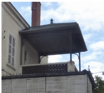
Terrasse couverte, structure métallique.
