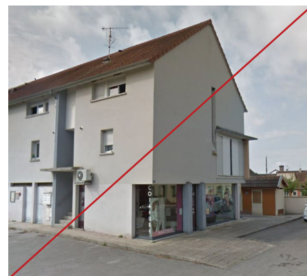
Multiplication des registres de percement qui complexifie beaucoup les façades.
