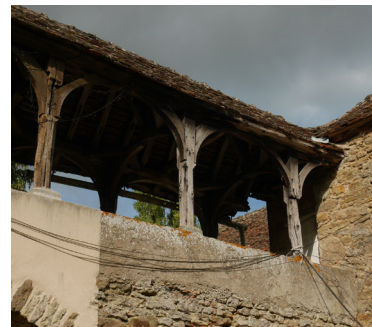
Galerie couverte extérieure en charpente.
