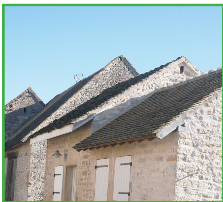
Couverture en laves traditionnelle avec débord en rive.
