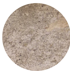
Enduit à la chaux naturelle
