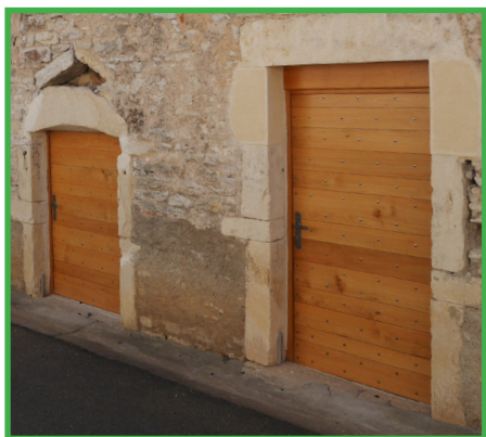
Portes double lame refaites à l'identique (en attente d'une mise en peinture).
