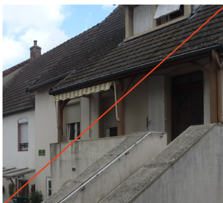
Enduit ciment, tuiles mécaniques, ajout de lucarne et store (Saint-Bérain-sur-Dheune)
