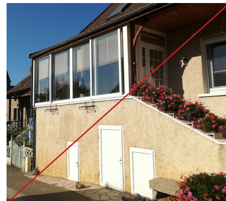
Espace couvert fermé par des menuiseries dont l'intégration pose question.
