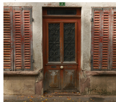
Porte en bois avec partie supérieure vitrée, traverse moulurée, imposte vitrée.
