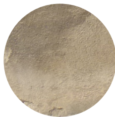
Enduit à la chaux naturelle
