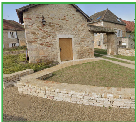
Muret en moellons de pierre de teinte homogène avec le bâti.
