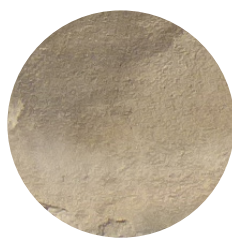
Enduit à la chaux naturelle
