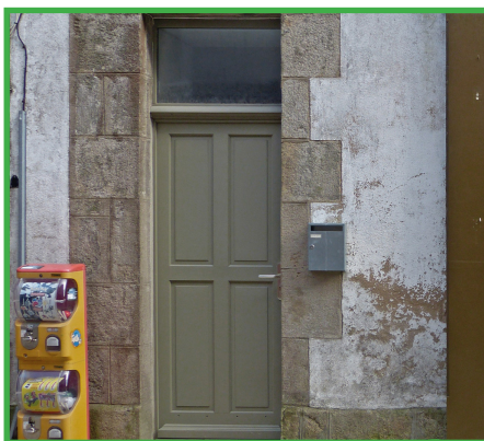
Porte pleine en bois plein à compartiments et imposte vitrée.
