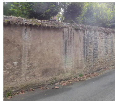
Mur de maçonnerie enduit à la chaux et couvert de tuiles creuses.
