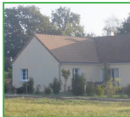
Couverture de pavillon en tuiles plates mécaniques.
