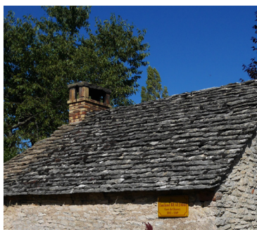
Laves calcaires posées en encorbellement.
