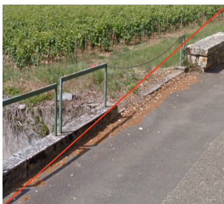
Muret reconstruit en parpaing enduit surmonté d'un garde-corps (Mercurey)
