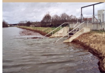
La digue d'Ouroux-sur-Saône (71)
