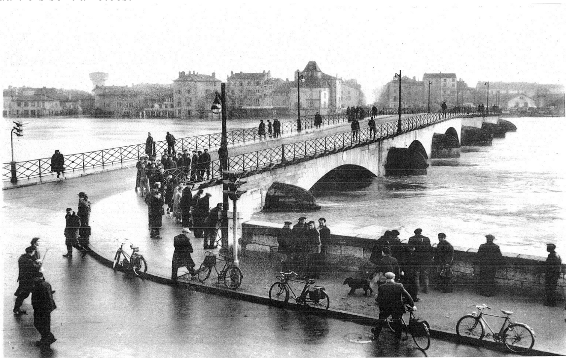
Mâcon, pont Saint-Laurent, crue de 1955
