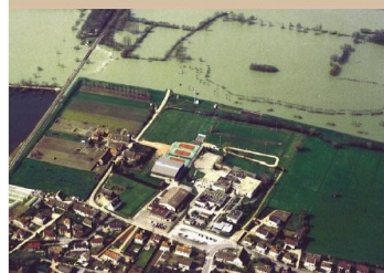
La digue de Saint Marcel (71)
