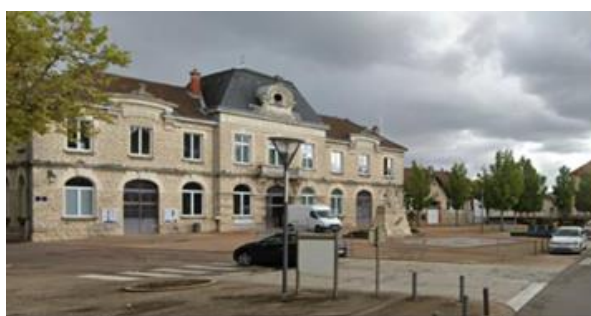
Edifice public Mairie de St Germain du Plain
