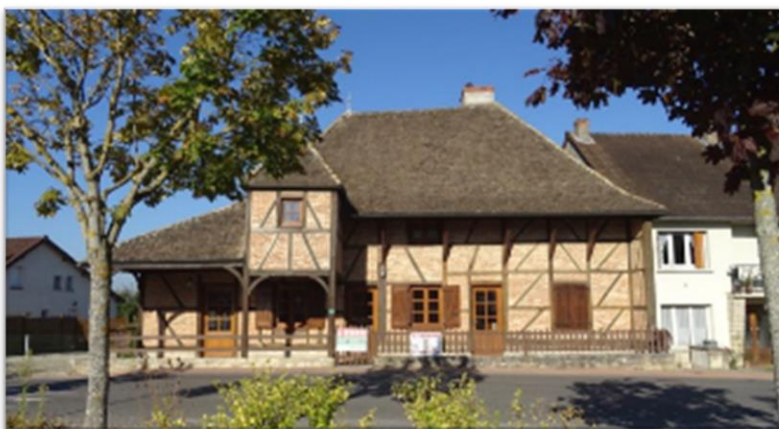
Figure 53 : L'Abergement de Sainte colombe, Mosaïque Environnement
