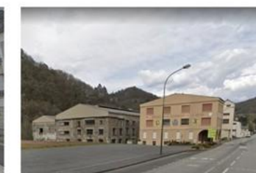
Av de la Gare (RD922)
