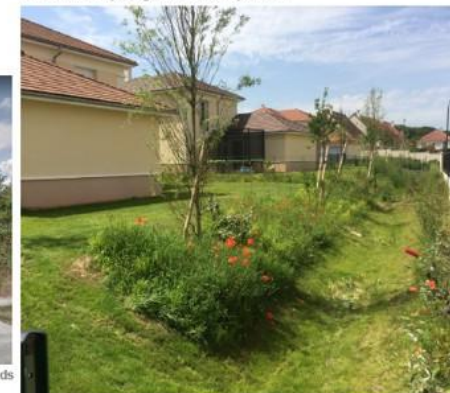
Gestion des eaux pluviales à ciel ouvert Site d'ATM - https://agence-atm.com/portfolio/
