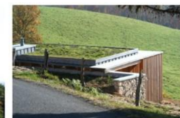
Lieu: Les fourmilières, Lacapelle Del Fraisse (15) Année: 2011 Équipe: Atelier d'architecture Simon Teyssou Catégorie: Habitat Maison Surface: 130 m 2 Client: Privé
