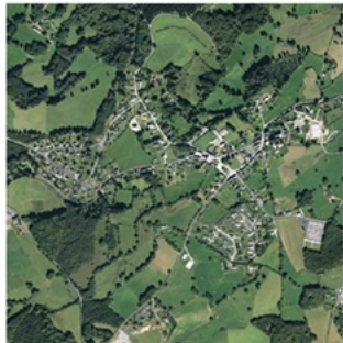
Saint-Exupéry-les-Roches et ses extensions à chaque entrée de bourg.
