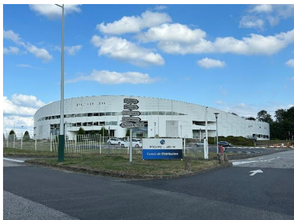
Site logistique Pierre Fabre
