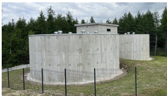
Vue sur le nouveau château d'eau
