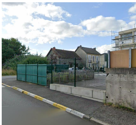
Vue sur la cour de récréation rénovée avec le potager pédagogique
