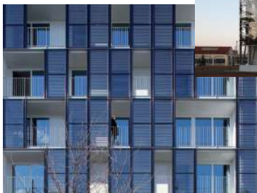
← Résilles solaires en façade (© Batiactu)
