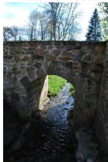
13 – Pont au-dessus du ruisseau des Sarrasins
