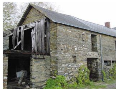
Le corps de ferme avant travaux
