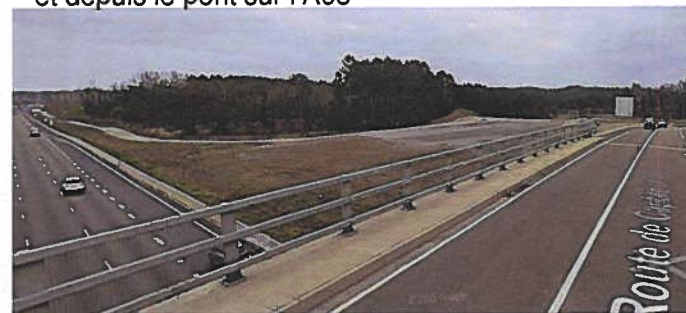
et depuis le pont sur l'A63
