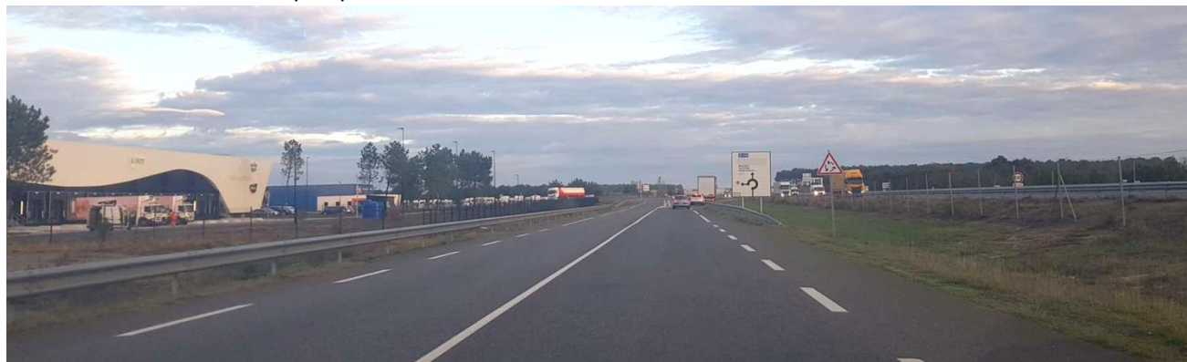
Photo 1- partie sud au droit de l'entreprise de transport de frais 'Le Saint' : La bande de recul est occupée par les bassins de rétention et les voiries.
