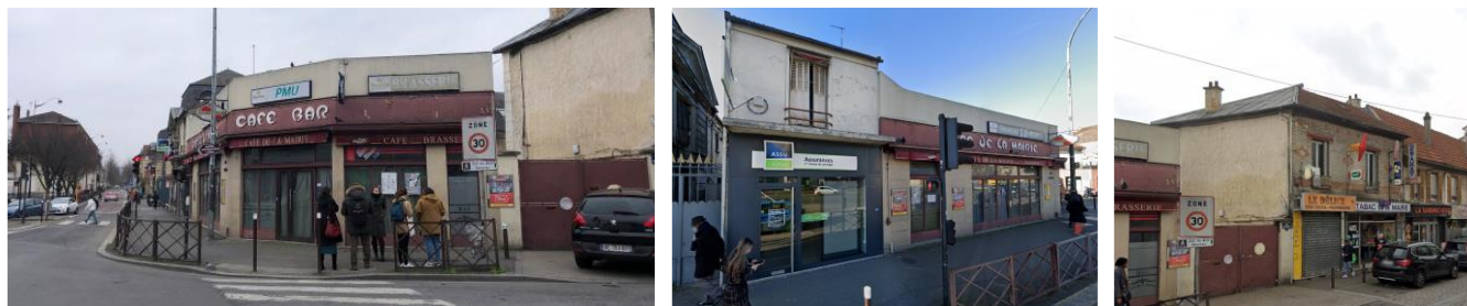
Photographies de l'entrée sud de la rue Carnot depuis l'avenue Marcel Cachin, Plaine Commune, 2023
