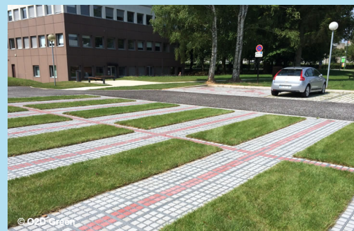
Revêtement perméable végétalisé des espaces de stationnement
