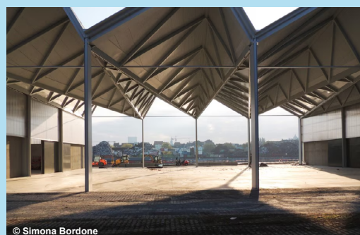
Intégration de l'espace de stockage au bâti
