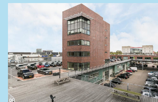
Espace de stationnement en toiture
