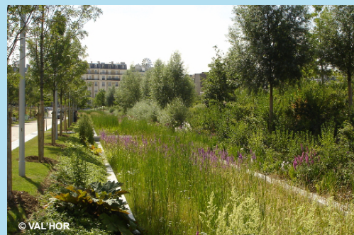
Noue végétalisée permettant la gestion des eaux pluviales
