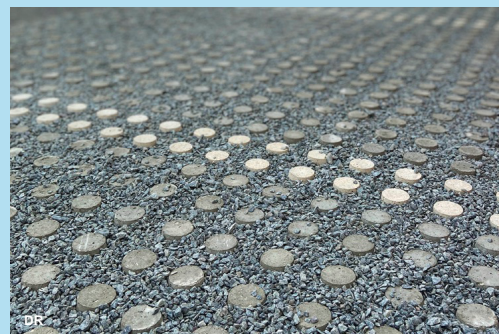
Revêtement perméable des espaces de stationnement
