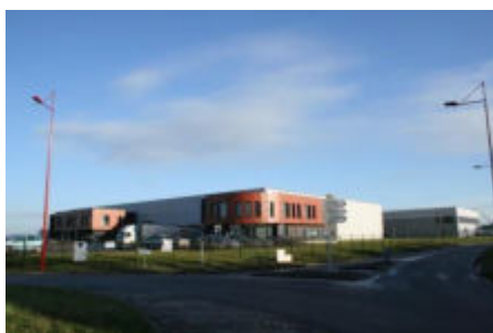
Parc d'activité de la Broye - ENNEVELIN
