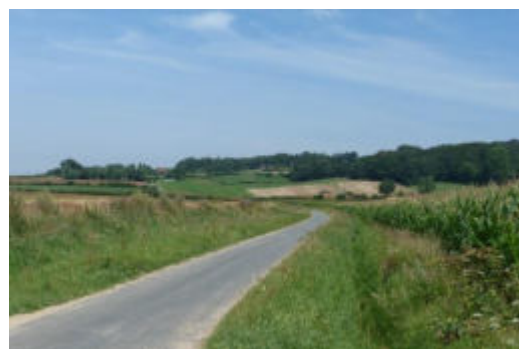
FIGURE 65 PENTE ONDULÉE DU MONT NOIR
