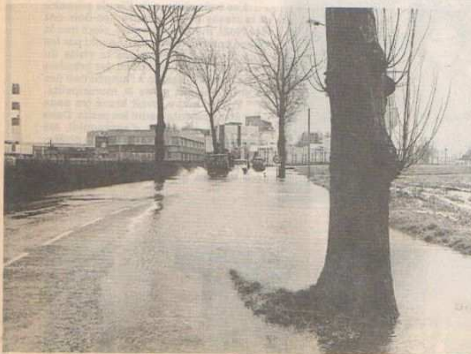
La route de La Gorgue à hauteur de l'usine Roquette est partiellement inondée.
