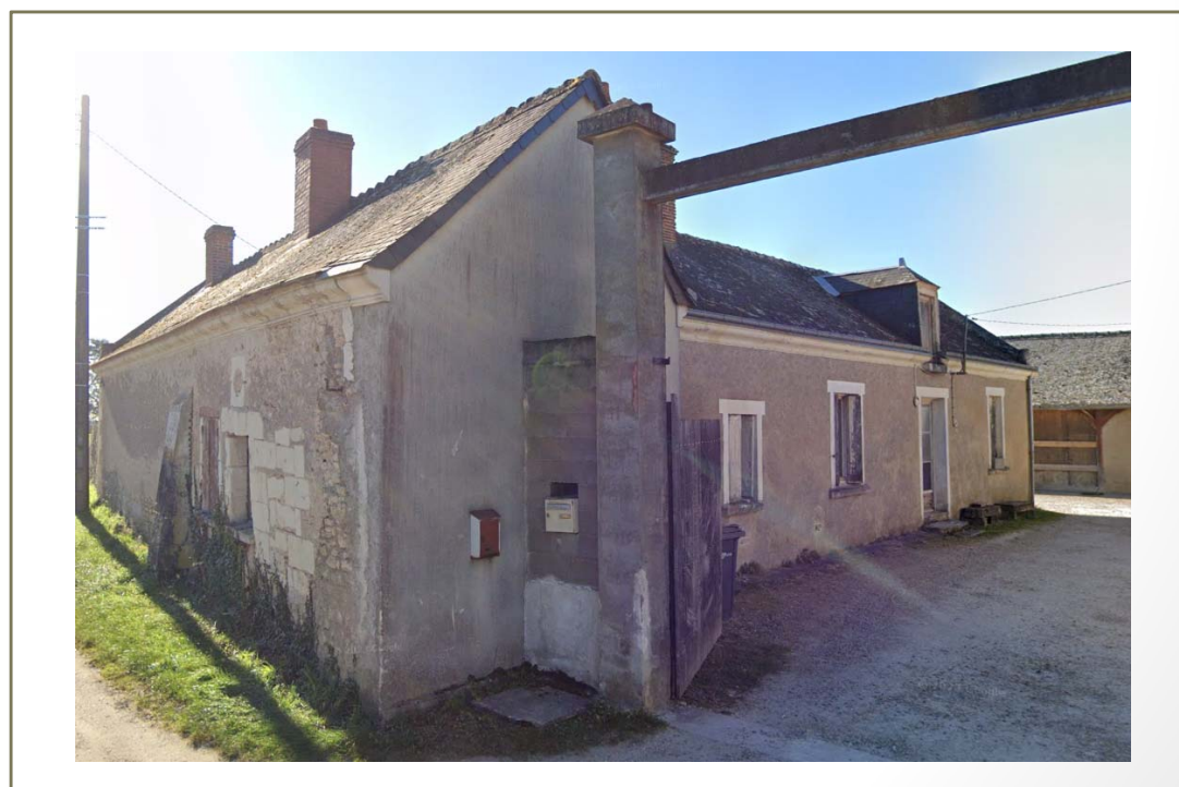
Photo(s) du bâti
