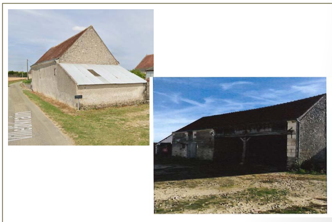
Photo(s) du bâti
