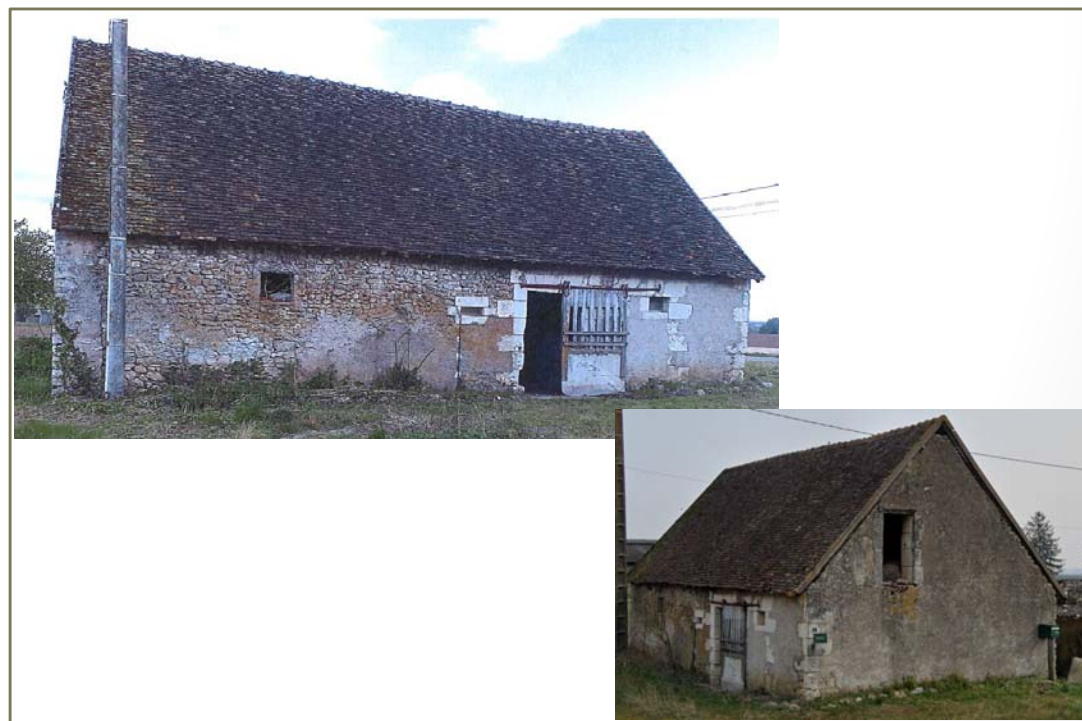
Photo(s) du bâti
