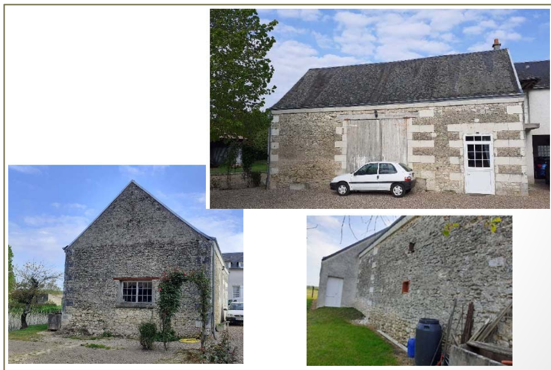
Photo(s) du bâti
