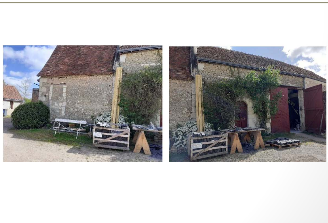
Photo(s) du bâti
