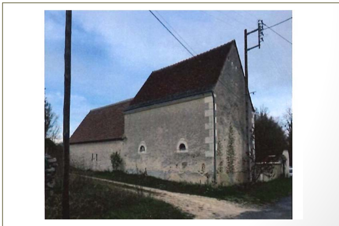
Photo(s) du bâti
