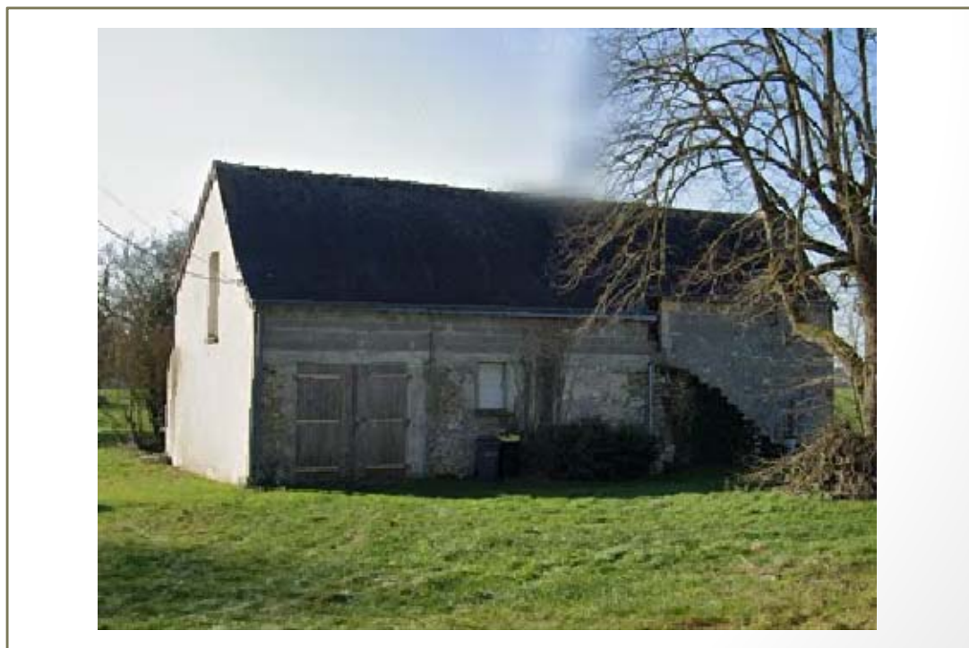
Photo(s) du bâti
