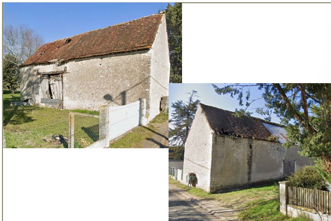
Photo(s) du bâti
