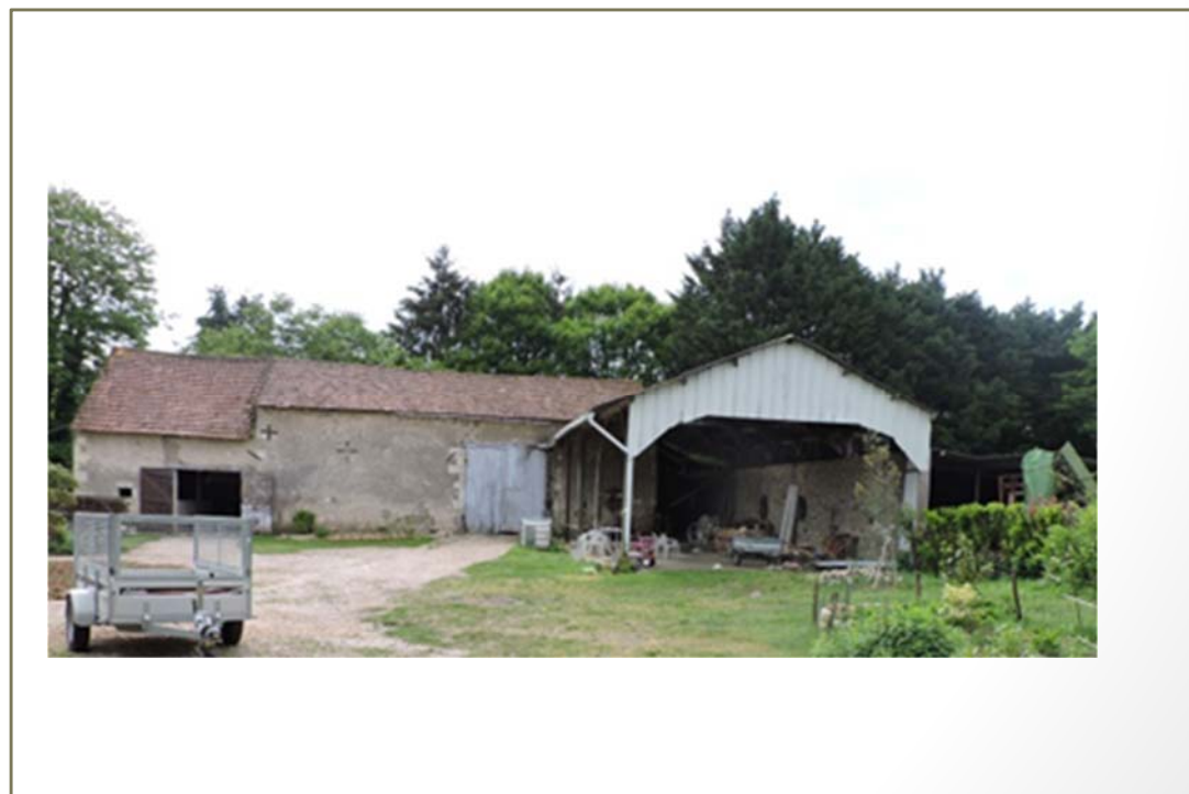
Photo(s) du bâti
