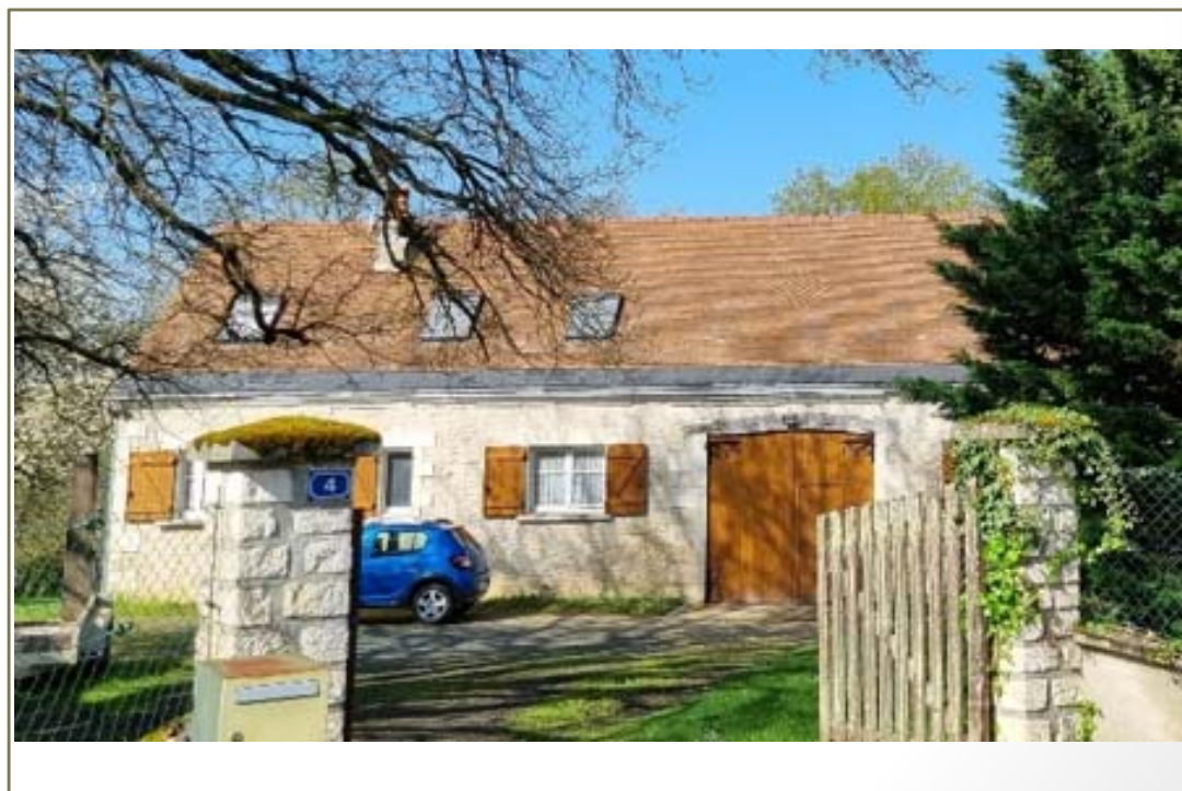
Photo(s) du bâti
