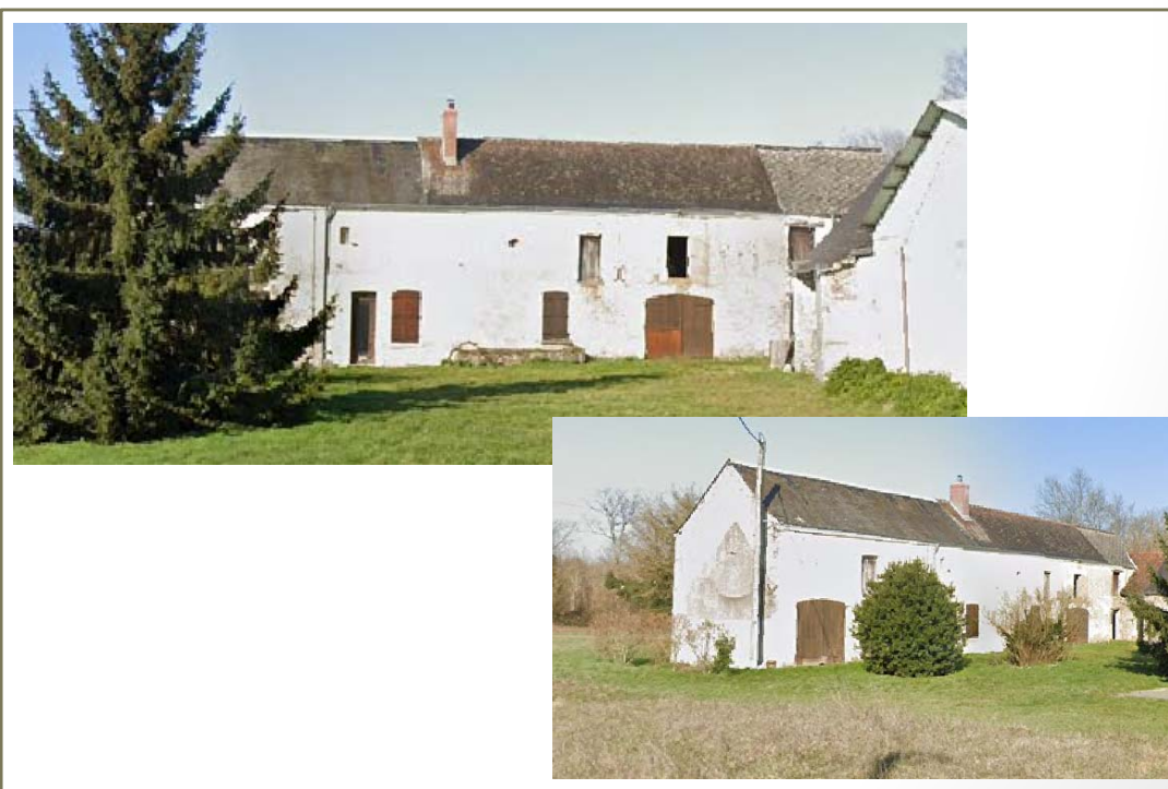
Photo(s) du bâti
