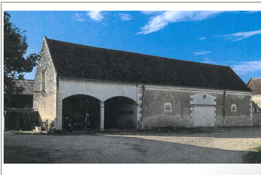
Photo(s) du bâti
