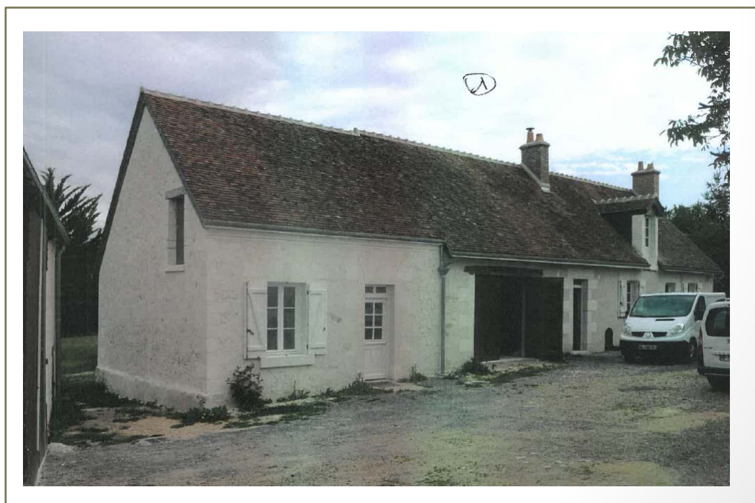
Photo(s) du bâti
