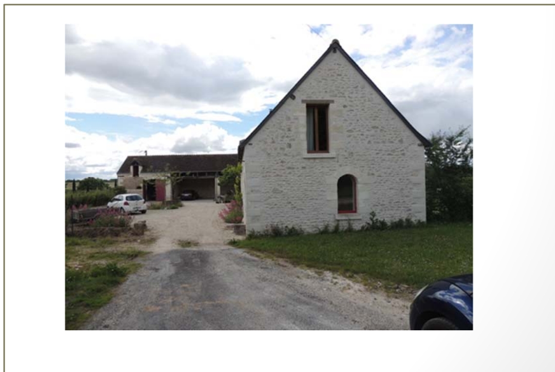
Photo(s) du bâti
