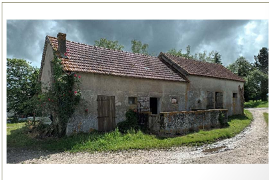
Photo(s) du bâti
