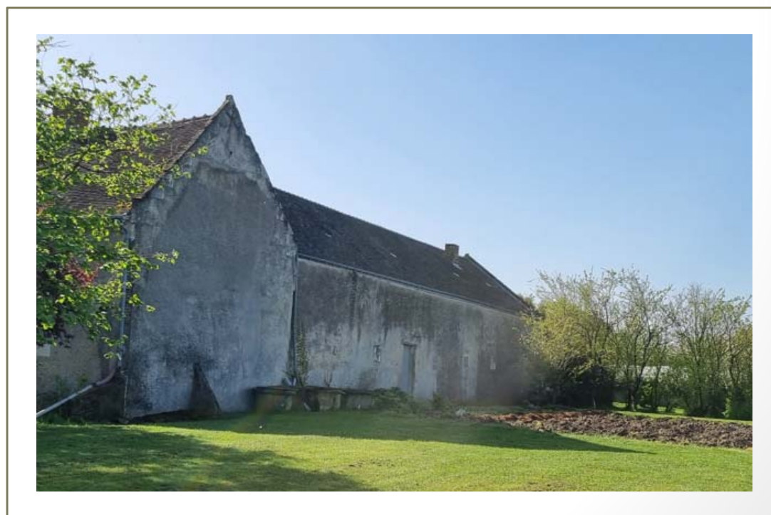
Photo(s) du bâti
