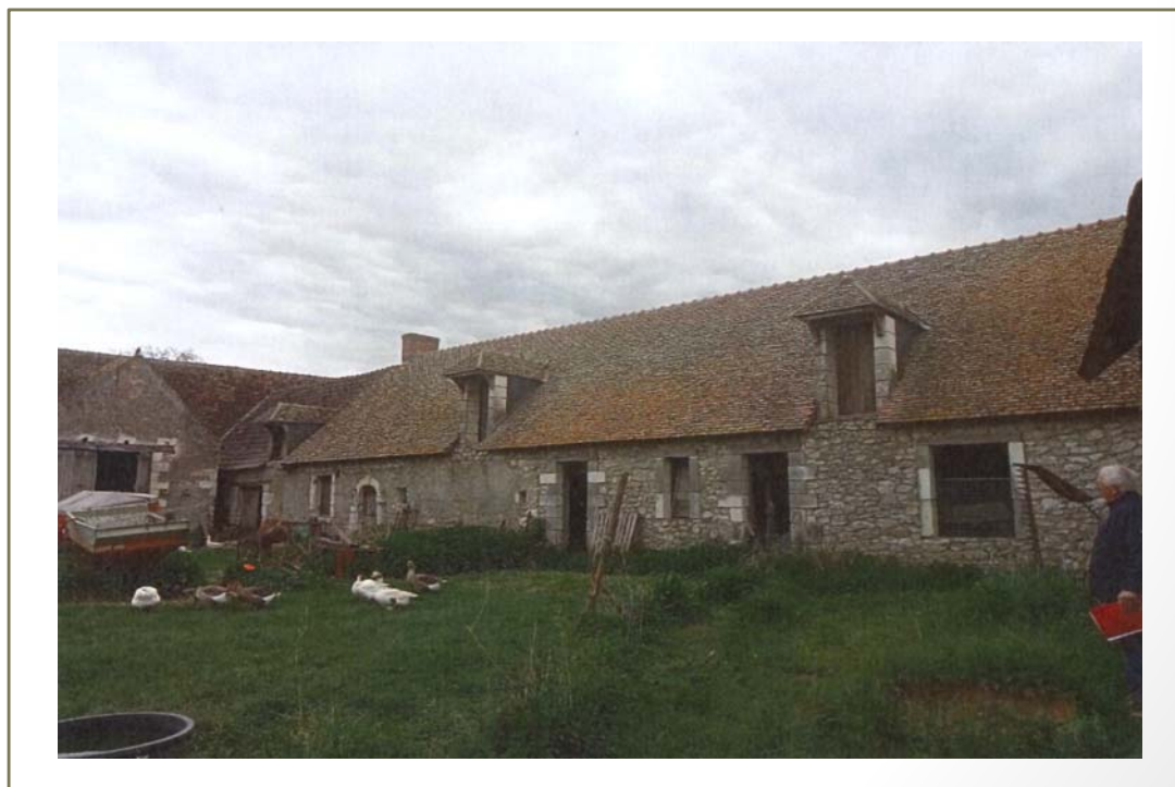
Photo(s) du bâti
