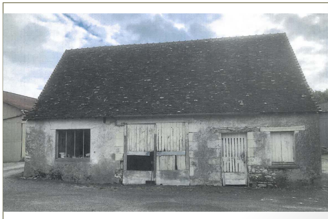
Photo(s) du bâti
