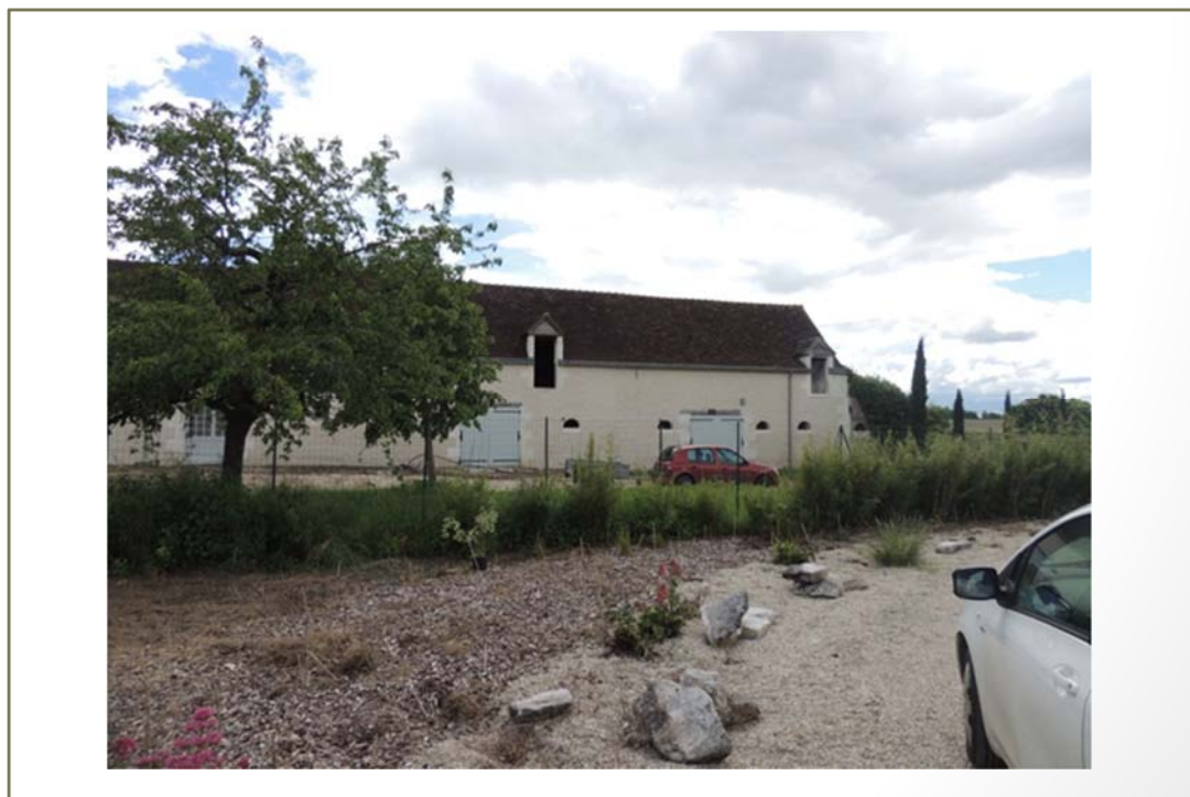
Photo(s) du bâti
