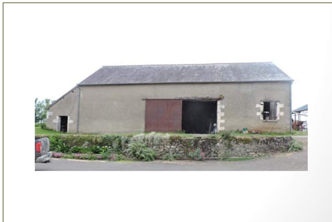
Photo(s) du bâti
