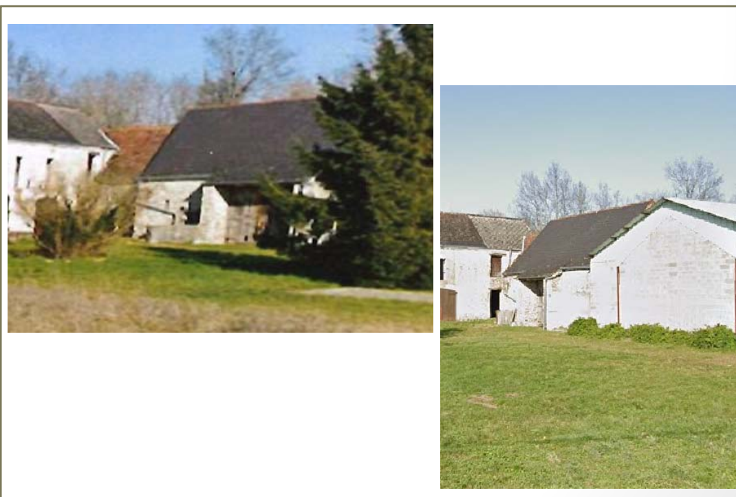
Photo(s) du bâti
