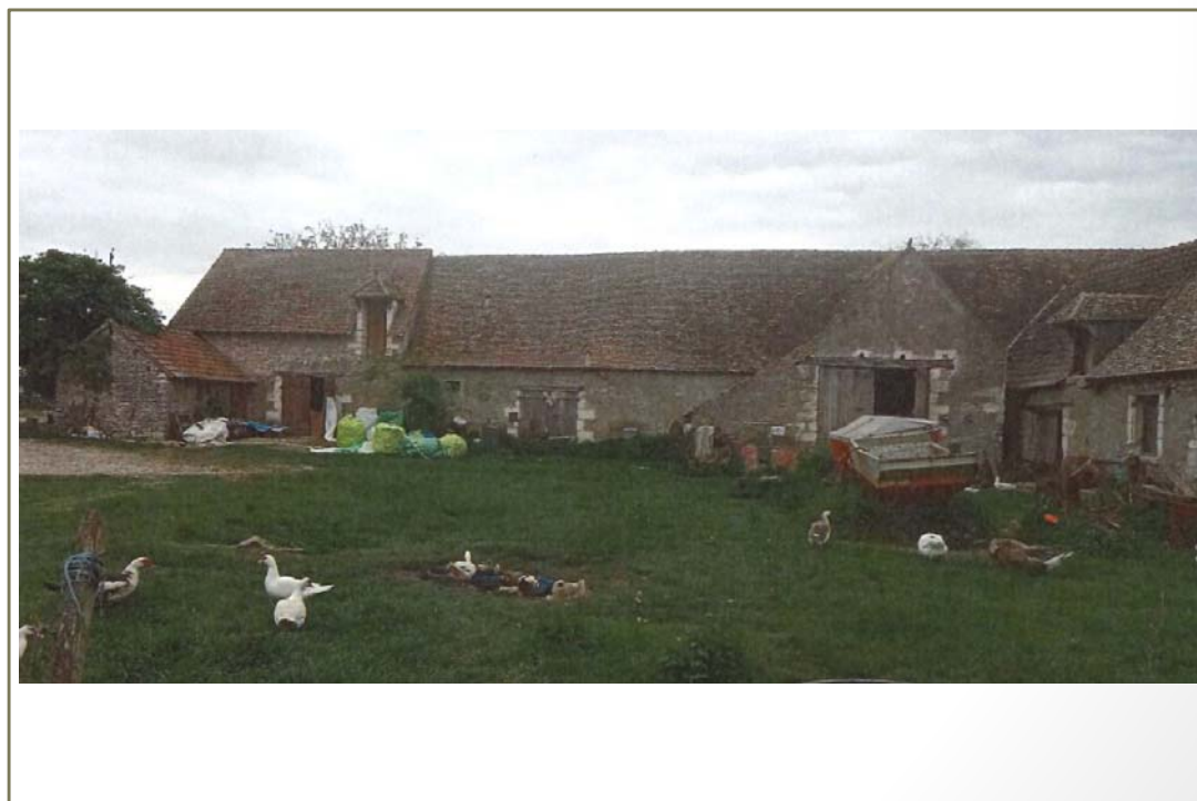
Photo(s) du bâti
