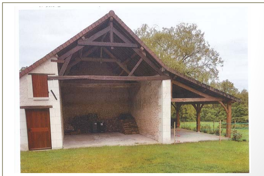
Photo(s) du bâti
