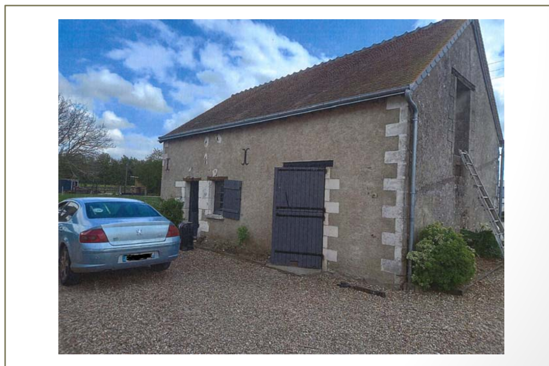
Photo(s) du bâti
