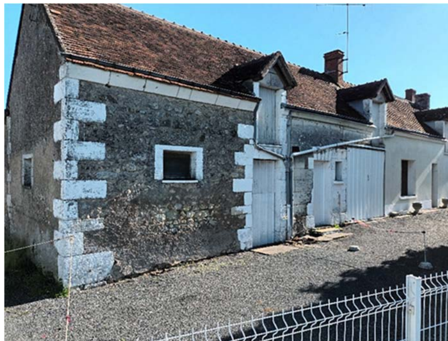
Photo(s) du bâti
