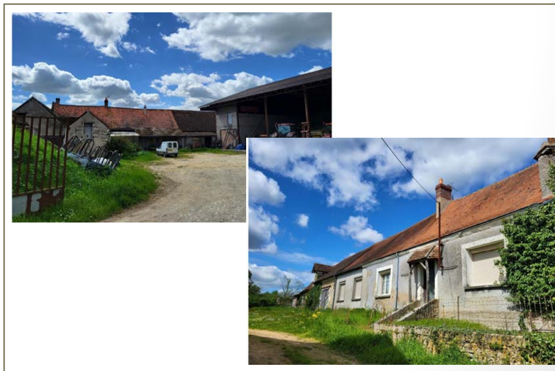
Photo(s) du bâti
