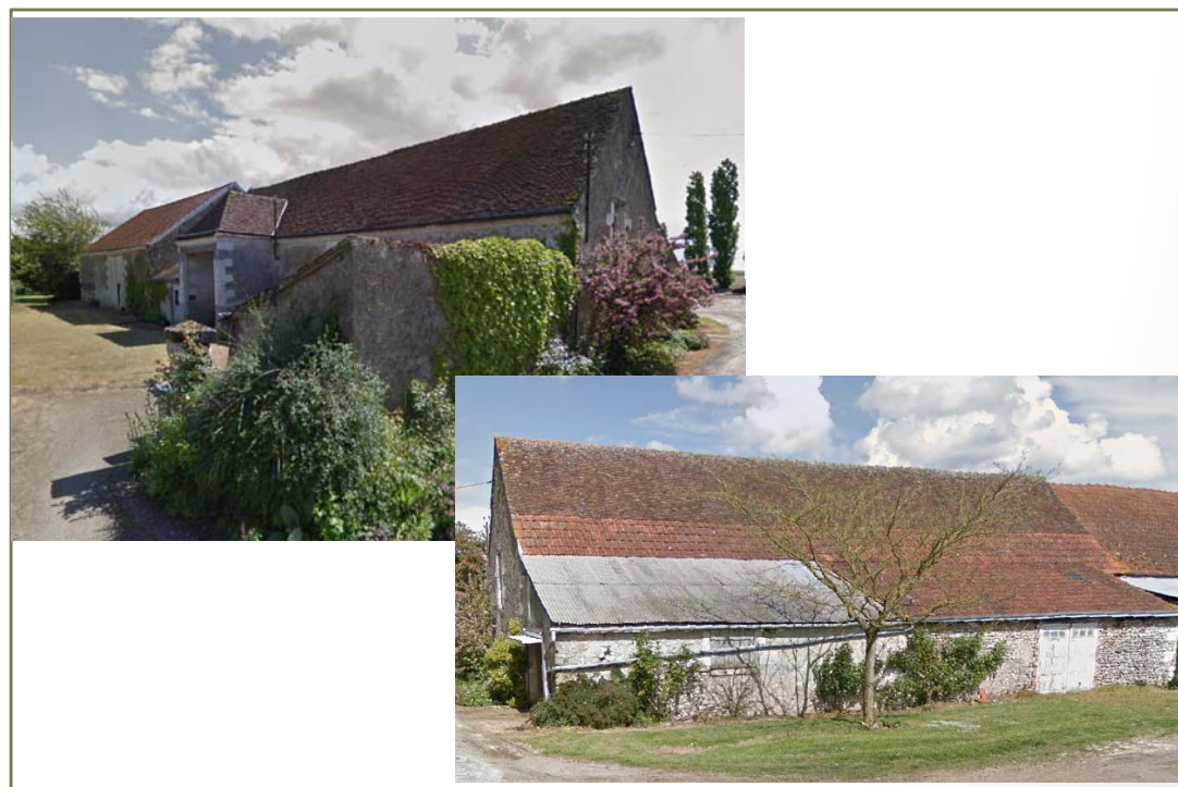
Photo(s) du bâti
