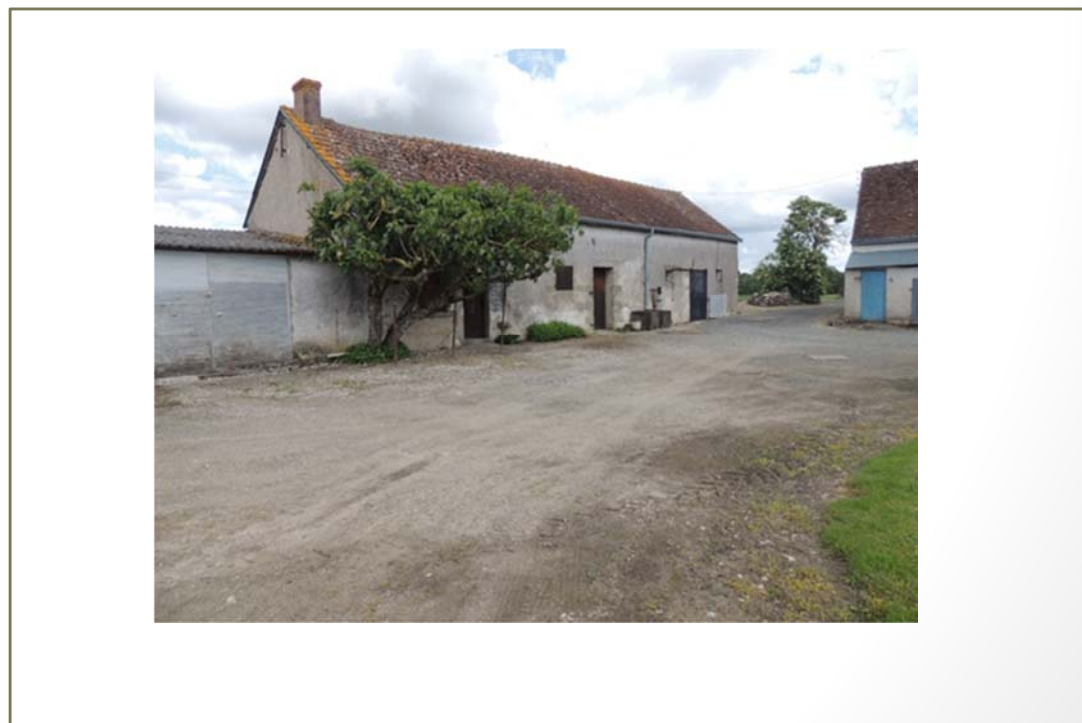
Photo(s) du bâti
