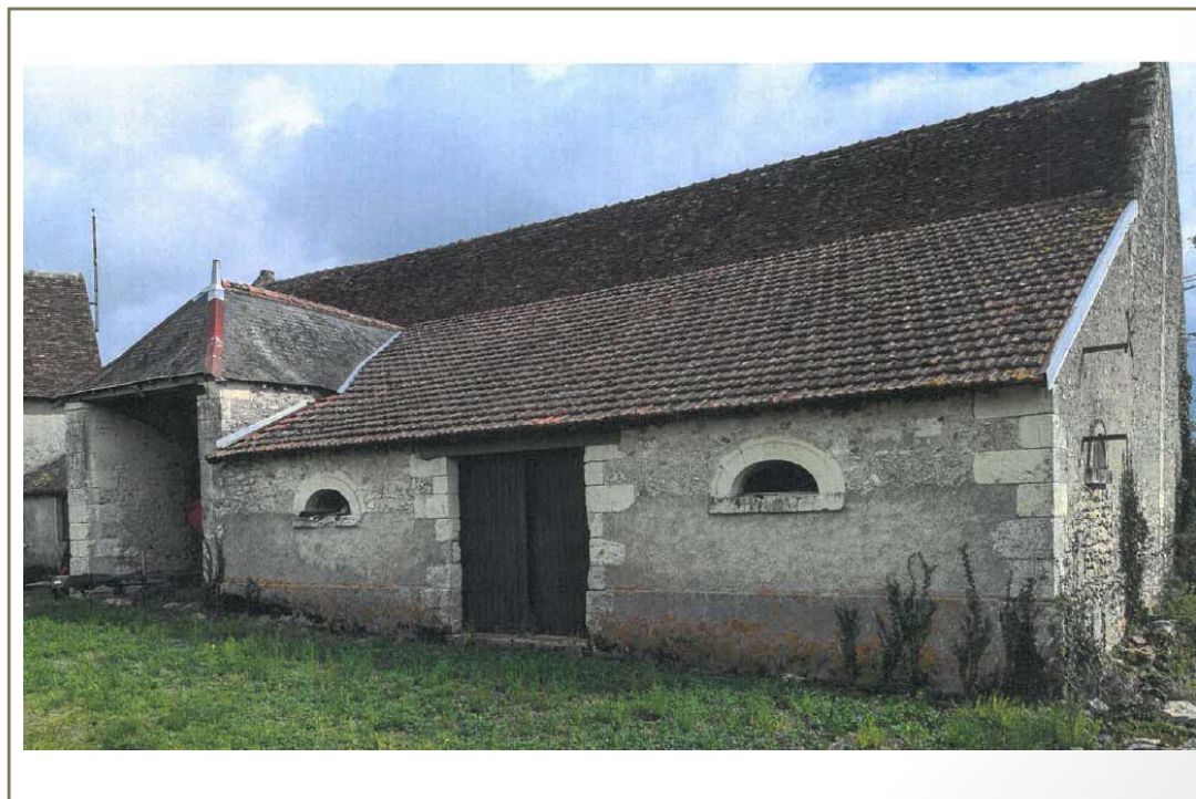
Photo(s) du bâti
