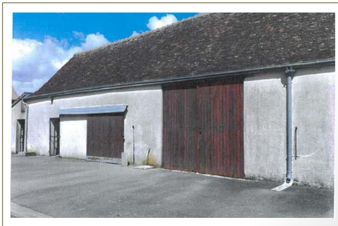
Photo(s) du bâti
