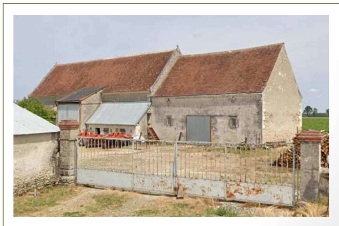
Photo(s) du bâti
