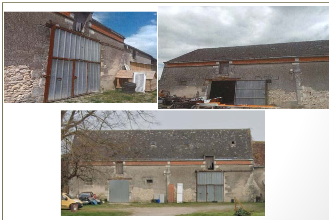
Photo(s) du bâti
