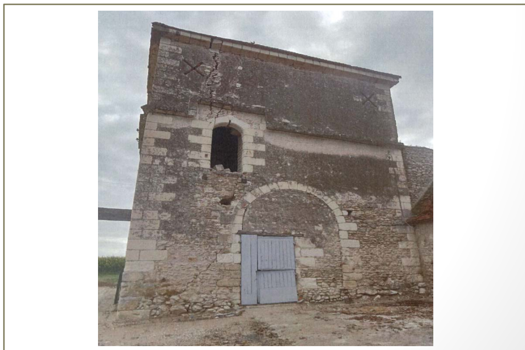
Photo(s) du bâti
