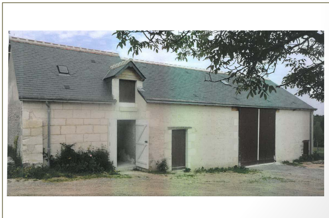
Photo(s) du bâti
