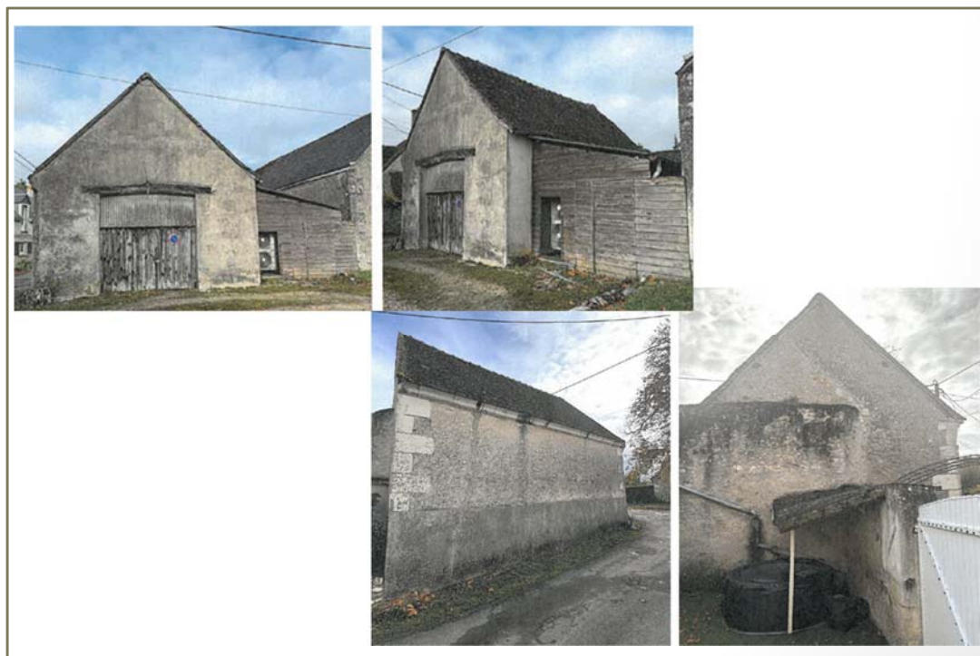
Photo(s) du bâti
