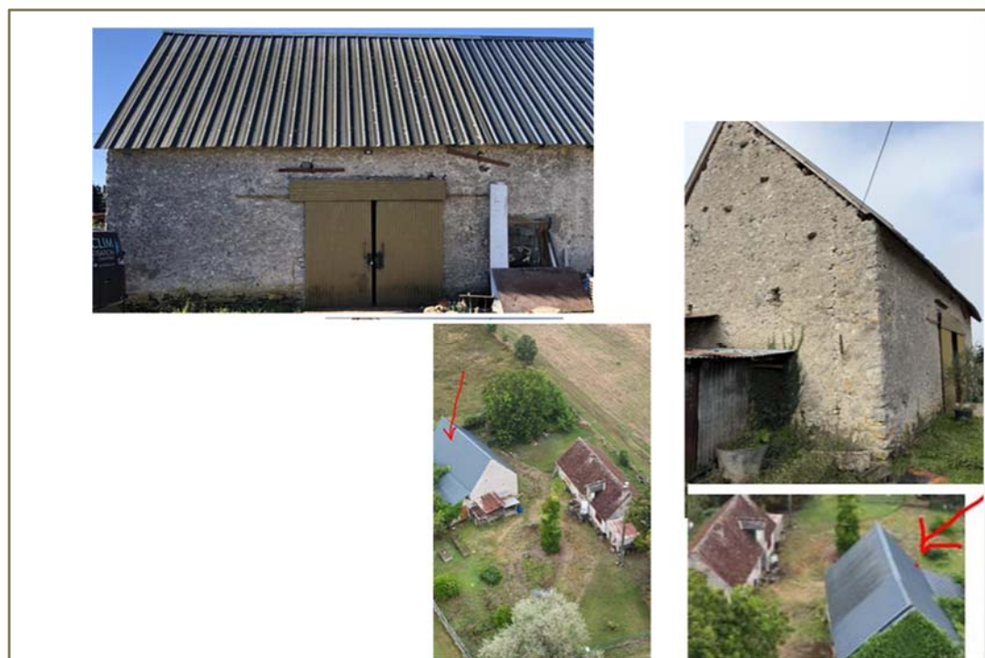
Photo(s) du bâti
