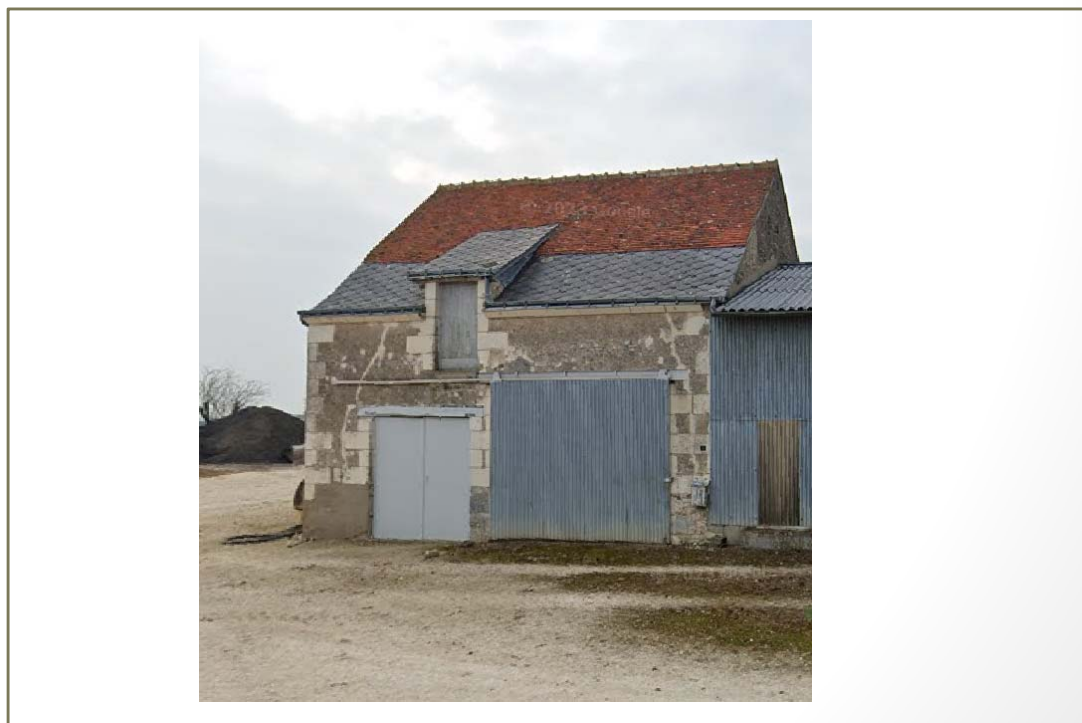
Photo(s) du bâti
