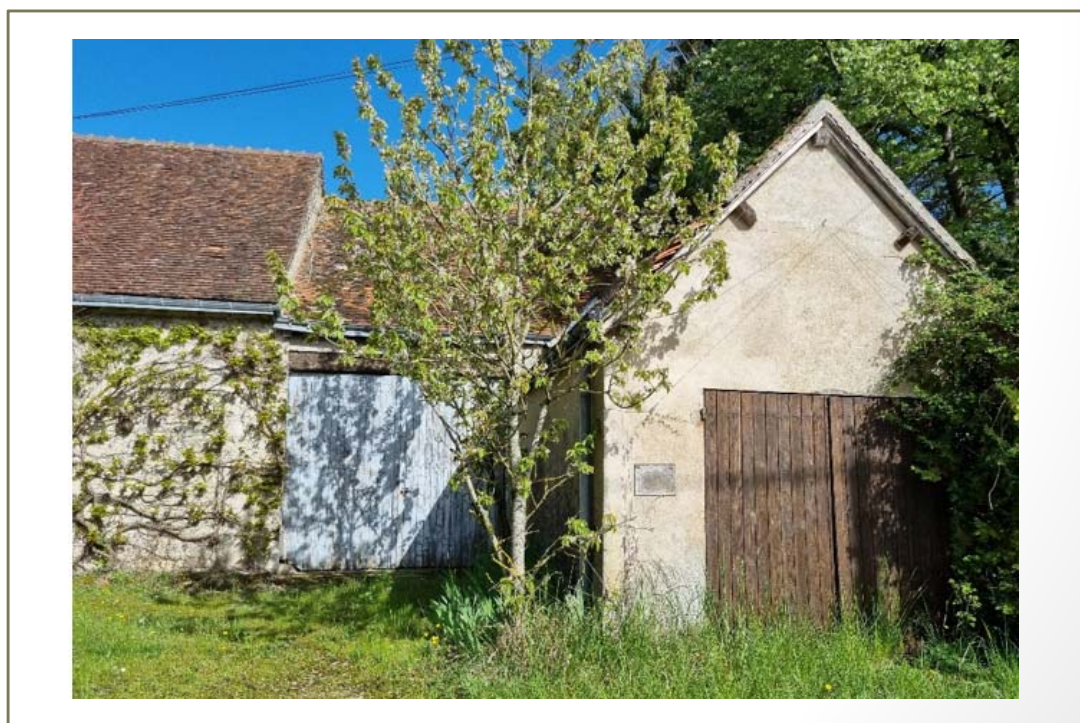
Photo(s) du bâti
