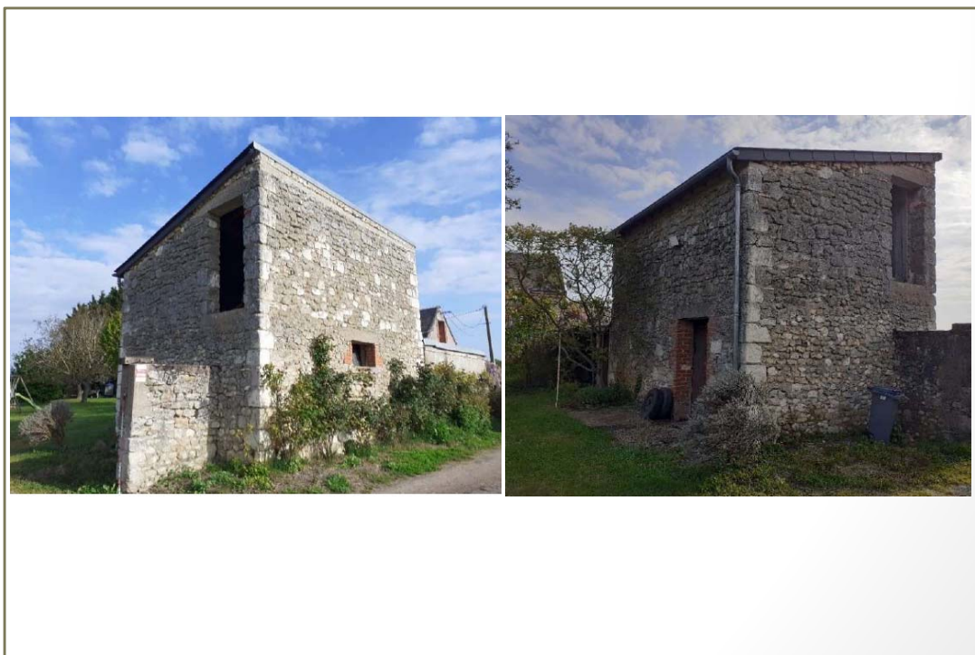
Photo(s) du bâti
