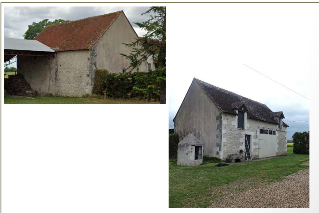
Photo(s) du bâti
