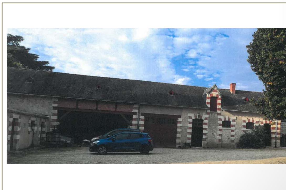
Photo(s) du bâti
