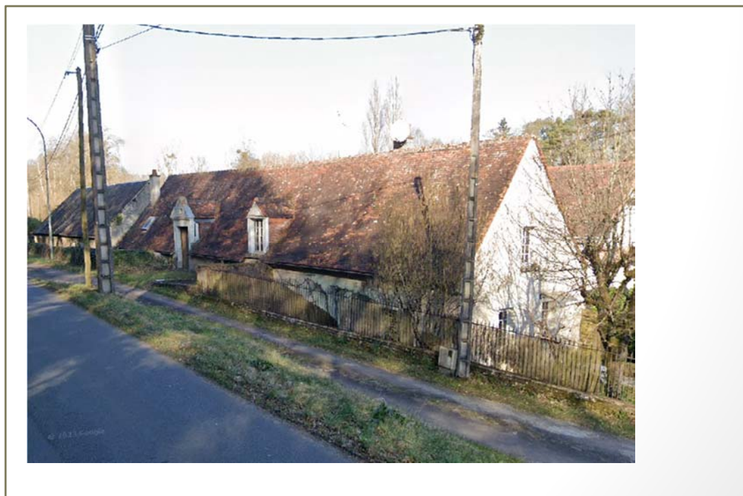
Photo(s) du bâti
