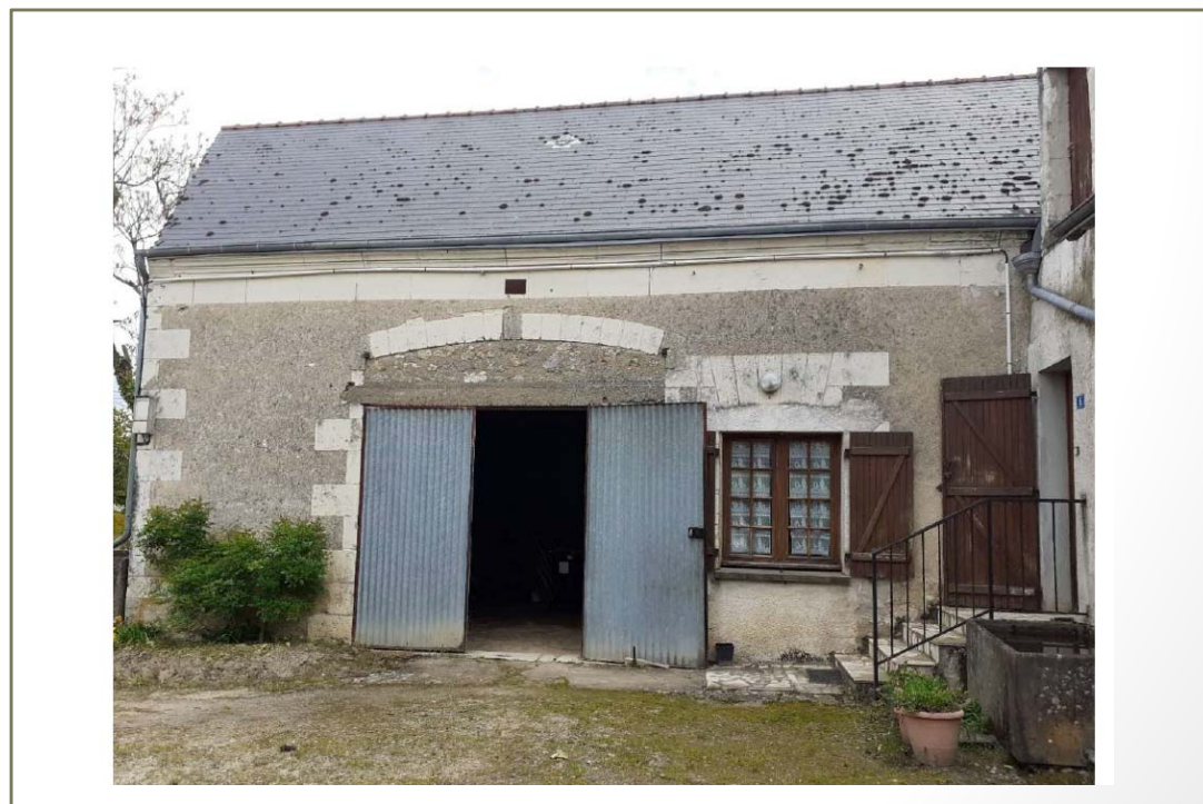
Photo(s) du bâti
