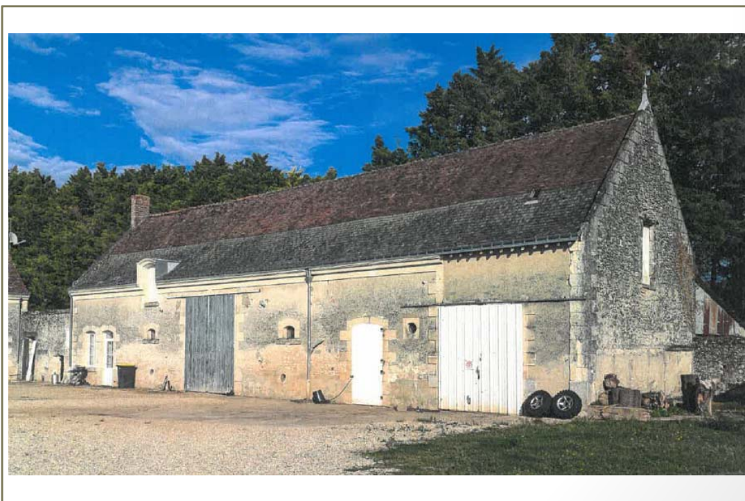
Photo(s) du bâti
