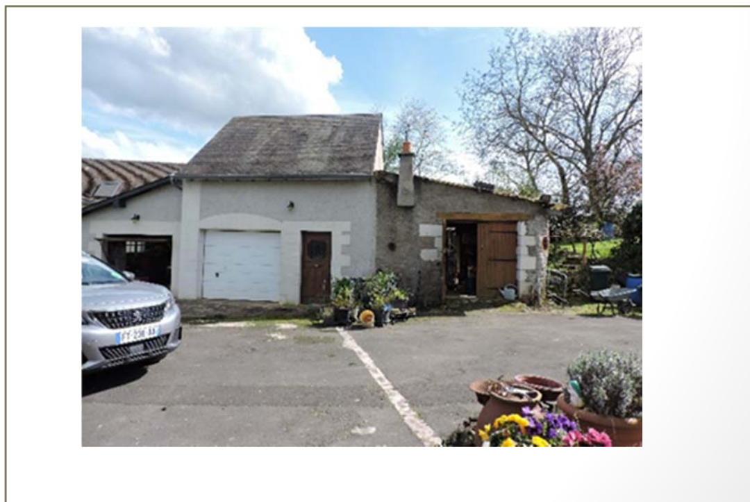
Photo(s) du bâti
