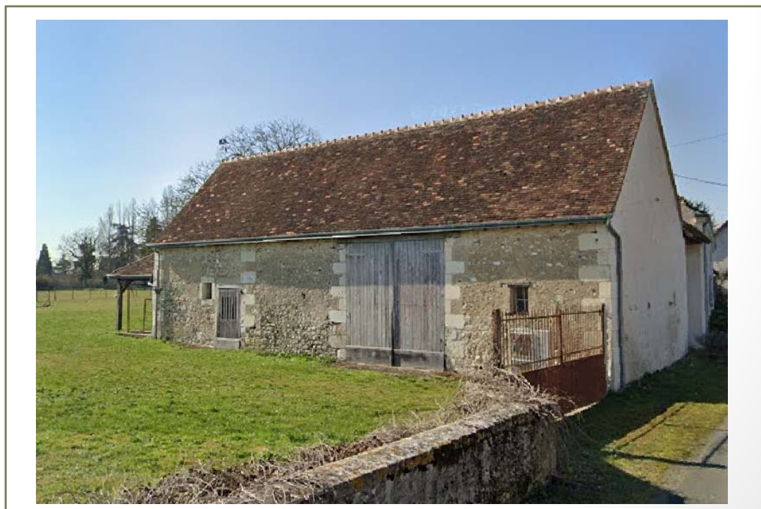
Photo(s) du bâti
