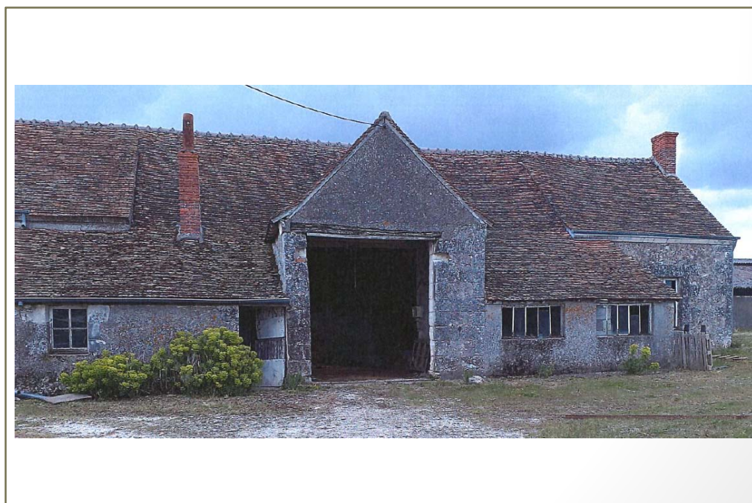
Photo(s) du bâti
