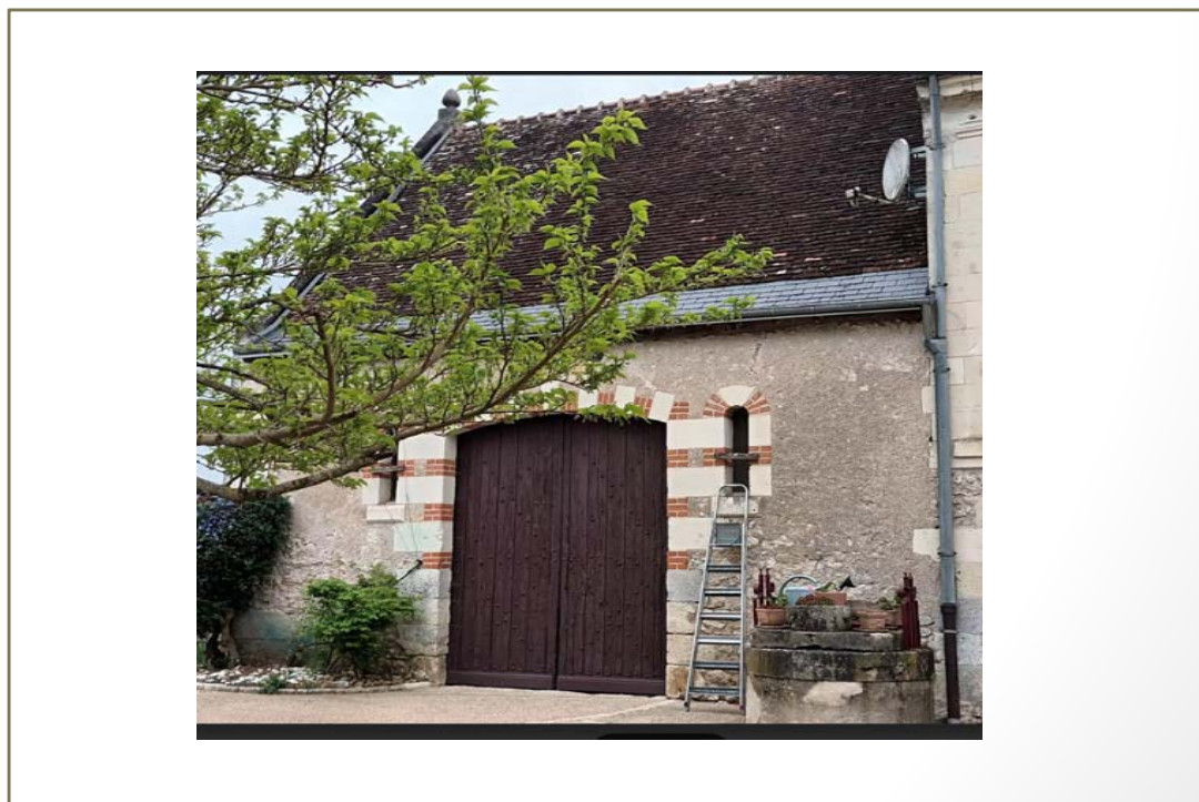
Photo(s) du bâti
