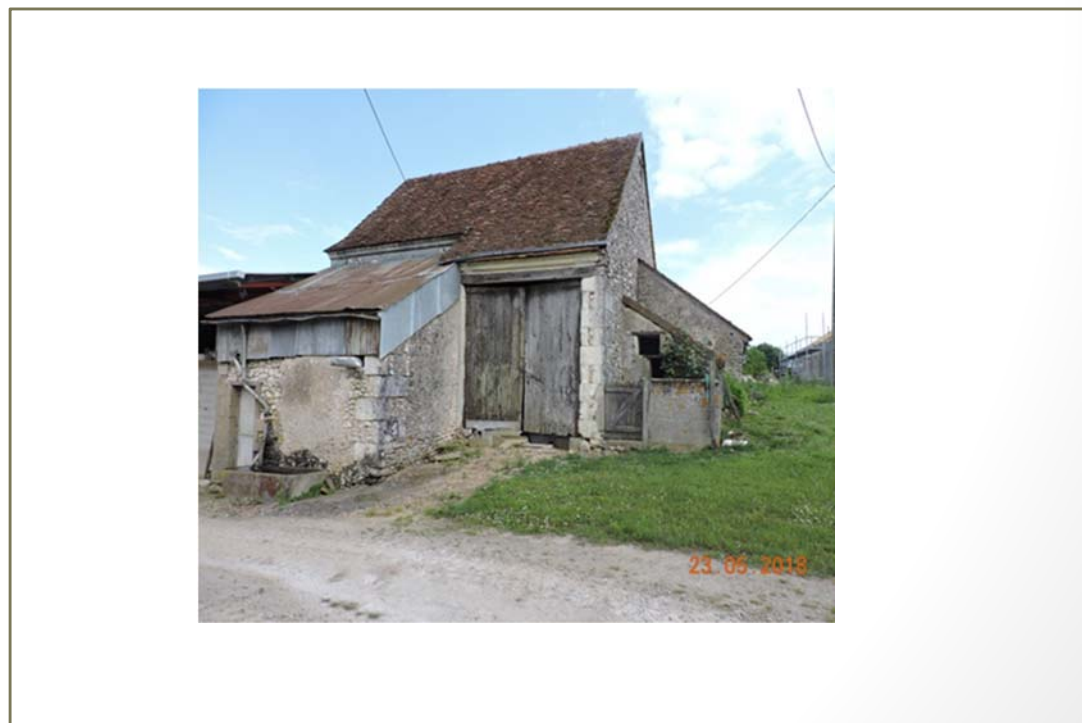
Photo(s) du bâti
