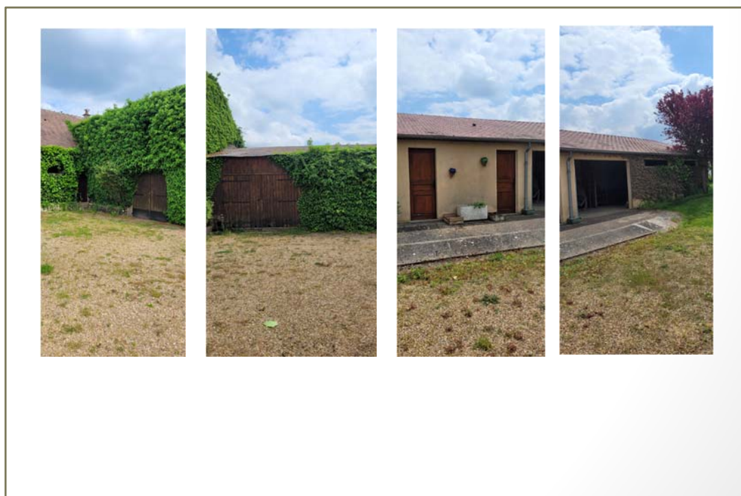
Photo(s) du bâti
