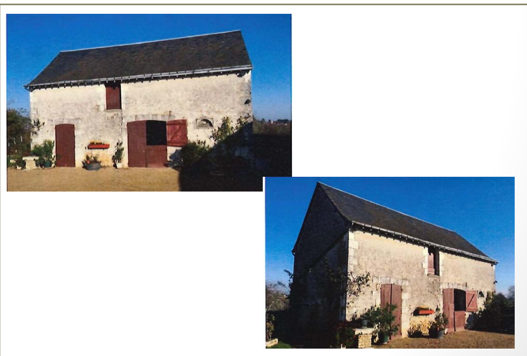
Photo(s) du bâti
