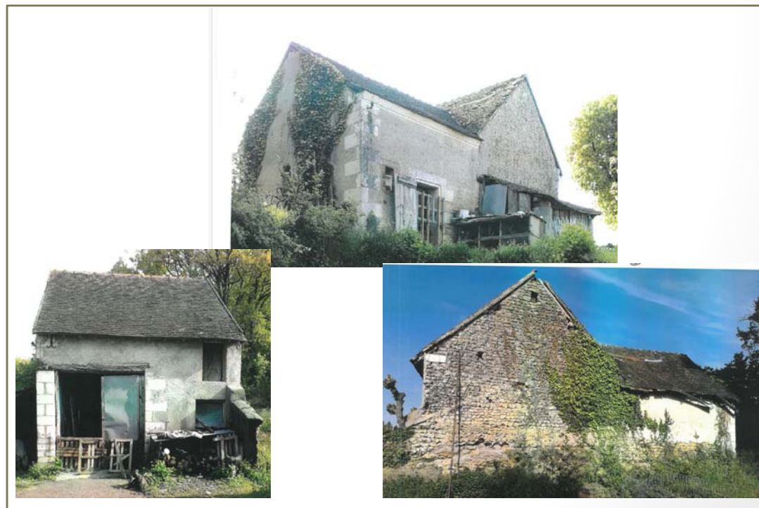
Photo(s) du bâti
