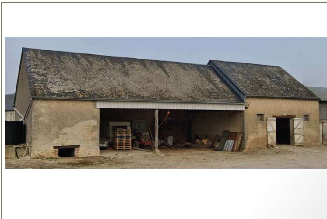
Photo(s) du bâti
