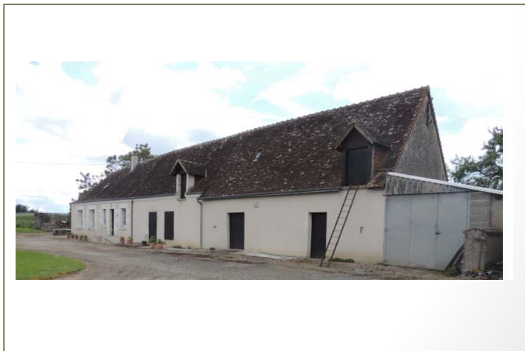
Photo(s) du bâti
