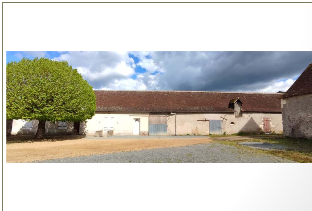
Photo(s) du bâti
