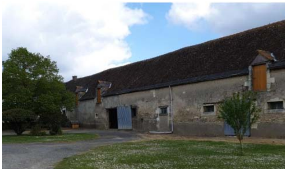
Photo(s) du bâti
