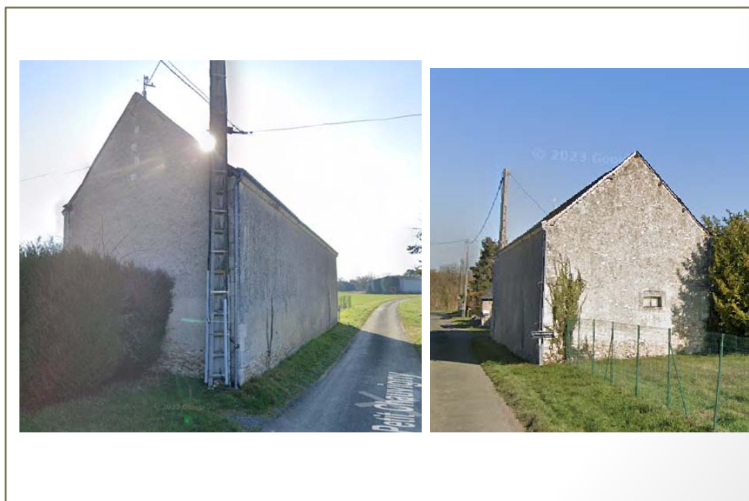
Photo(s) du bâti
