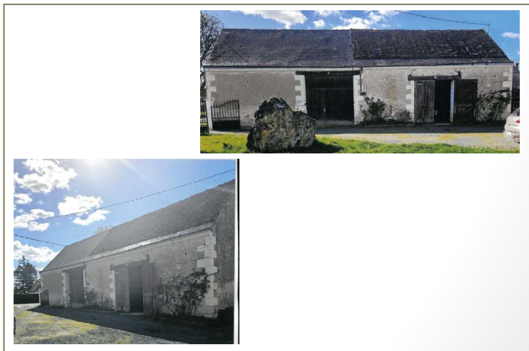
Photo(s) du bâti
