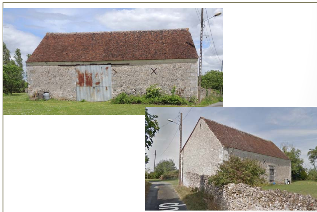
Photo(s) du bâti
