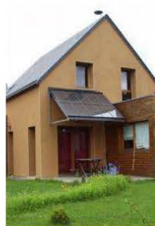
Panneaux thermiques formant une grande marquise au-dessus d'une baie et panneaux couvrant un barbecue.
