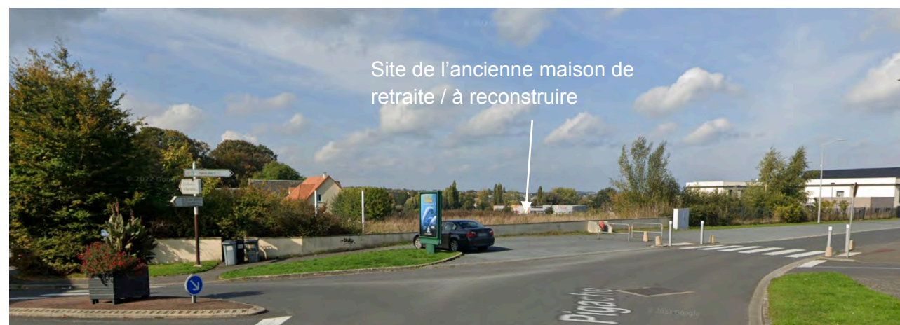
Photo 1. Vue sur l'ancienne maison de retraite / Maps
