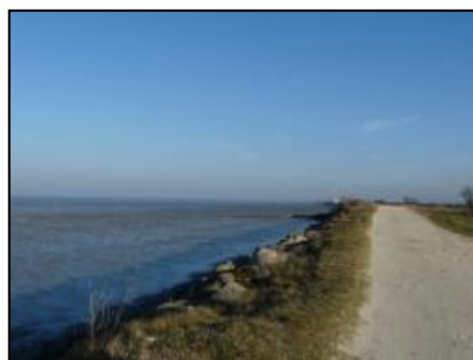
Figure 7 - Chemin sur la digue
