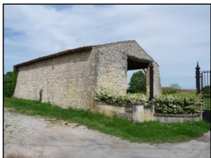
Corps de ferme à St-Vivien-de-Médoc
