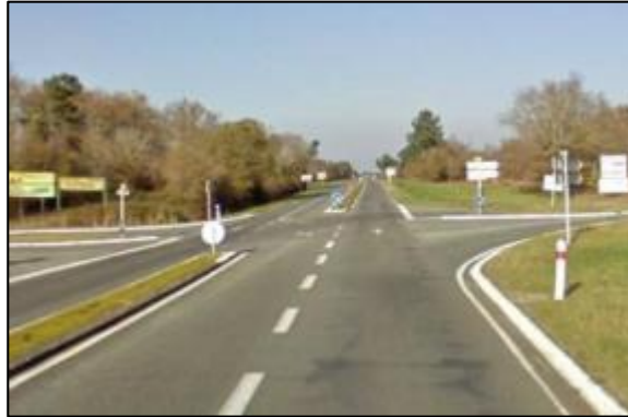
Figure 2 : RD 1215 au niveau du croisement avec la D1E4
