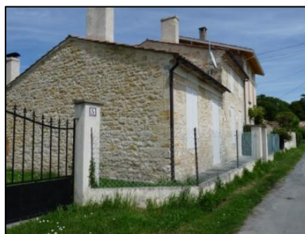
Figure 17 – Ancienne ferme réhabilitée
