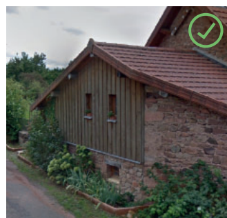
Utilisation de bois pour la rénovation du bâtiment ancien à Mussy sous Dun et bonne proportion des ouvertures tout en conservant les murs existants en pierre
