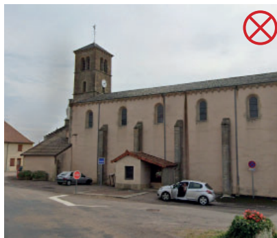
Espace public très minéral et peu accueillant pour le piéton au pied de l'église de Vauban. Les abords de l'église pourraient être plantés ou accueillir des espaces de pause pour le passant. Le traitement des pieds de façades valorise le bâtiment lui-même.
