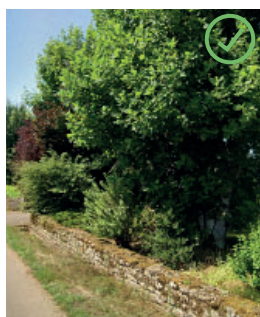
Le muret ancien a été maintenu et accompagné de plantations arbustives.
