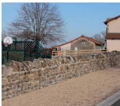
Exemple de revêtement de sol qui permet de marquer une zone dédiée au piéton, qui s'intègre facilement dans le paysage et qui n'imperméabilise pas le sol
