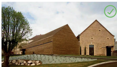
Extension d'un ancien corps de ferme contemporain, avec utilisation de revêtement bois qui s'adapte bien au paysage en reprenant les volumes et les teintes traditionnelles - Centre Léonce George, Chauffailles
