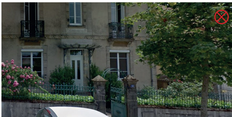
Conservations des grilles et portails. Mais malgré des menuiseries type «petits bois», la proportion du découpage des carreaux et l'utilisation du PVC marquent trop la façade et les coffrets des stores sont visibles. Il serait préférable de les teindre dans une couleur plus foncée ou de les réaliser en bois. Il en va de même pour la porte d'entrée
