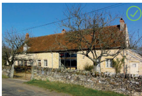
Bons exemples de rénovation d'une ancienne ferme typique à Baron, Grand Charolais : emploi de la grande porte pour baie vitrée et respect des teintes. ©Charte de qualité architecturale et paysagère du Charolais Brionnais
