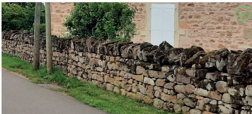
Bord de route et pied de clôture végétalisé, qui permet de gérer une liaison douce, agréable et qui peut gérer une partie des eaux pluviales
