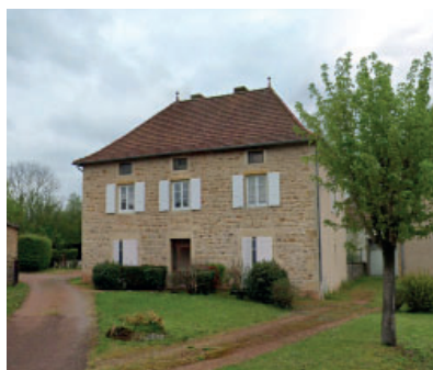
Maison de bourg isolée à Saint Maurice Lès Chateaufort
