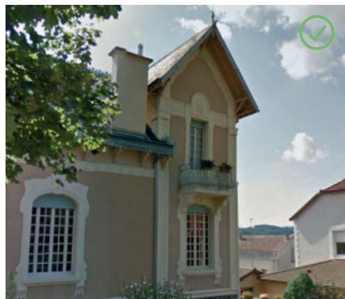
Conservation des modénatures, finitions et menuiseries à Chauffailles
