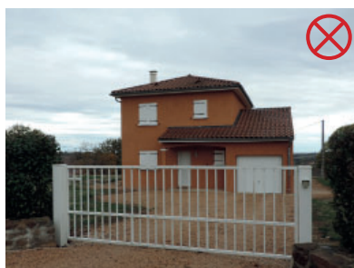
Maison inadaptée de style provençale (teinte trop marquée, colonne avec corniche...) Portail trop clair.
