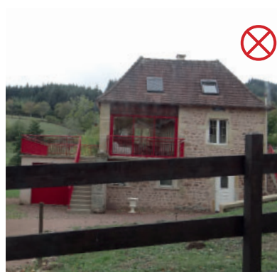
Belle maison de bourg ancienne. Le dessin des menuiseries et de la porte est adapté, mais leur revêtement en PVC blanc est trop voyant. L'ajout de garde corps, d'une porte de garage et d'une baie vitrée rouge vif est trop marqué - Saint Racho
