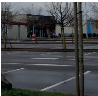
Exemple de revêtement de sol très fonctionnel pour les voitures, mais qui n'est pas forcément pertinent au regard de la qualité paysagère, de l'intégration du piéton, de la gestion de l'eau ou encore de la biodiversité
