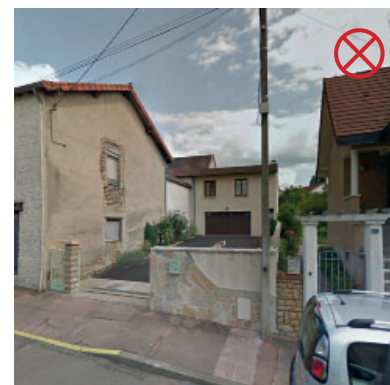
Maison implantée en retrait de la rue, en rupture de l'alignement de façade et qui donne une vue directe sur un espace de stationnement. Cette «cour» pourrait être accueillie de la végétation pour structurer la rue, isoler la maison et offrir un espace plus agréable
