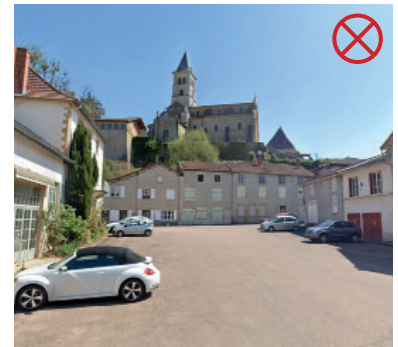
Centre bourg de Chateauneuf, avec un point de vue sur l'église, un revêtement imperméable et un aménagement trop minéral destiné au stationnement. On pourrait ajouter de la végétation aux pieds des façades par exemple.
