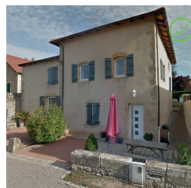
Rénovation de façade avec un bel enduit, mise en valeur des pierres, intégration du coffret dans le muret. Point négatif sur la porte en PVC trop blanche et au style peu intégré qui surcharge la façade. Elle serait préférable en bois avec une vitre simple.
