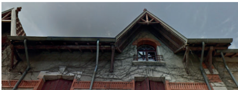
Modénature et détails de charpente à Chauffailles.
