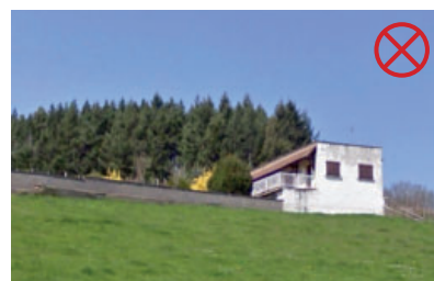
Maison trop impactante par ses proportions (façade cubique avec toiture plate), et par son enduit blanc qui ne correspond pas aux teintes locales, à Saint Racho
