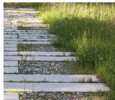
Exemple de revêtement de sol qui marque un cheminement tout en désimperméabilisant le sol, qui est adapté pour un contexte peu urbain
