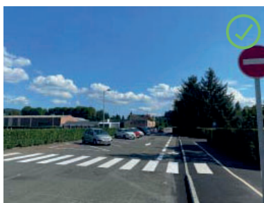
Bande cyclable installée près du Collège Jean Mer-moz - Chauffailles
