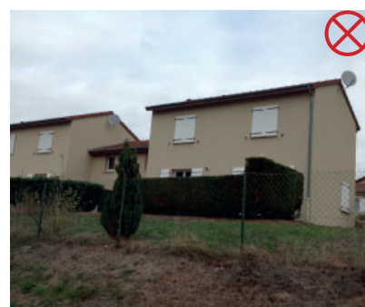
La haie taillée de thuyas sert à isoler la construction des regards mais elle la coupe surtout du reste du jardin. Une haie variée le long de la clôture rendrait le même service tout en embellissant les alentours
