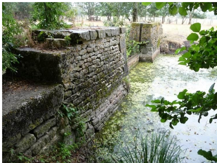
Batardeau sur le Mignon
