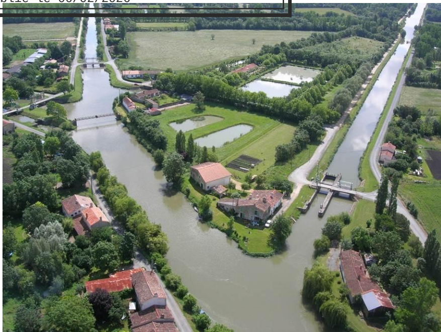
Nœud hydraulique de Bazoin - La Ronde
