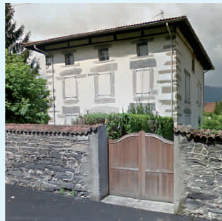
Exemple de maison «bourgeoise» avenue du Grésivaudan
