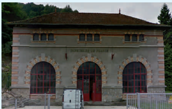
La centrale hydroélectrique
