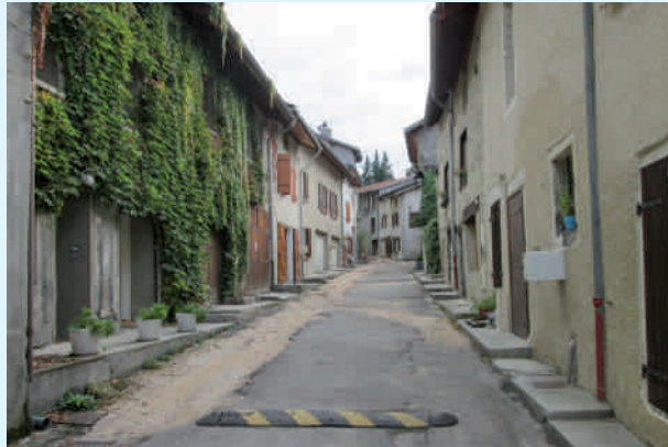
Maisons de rue formant la Vieille Rue
