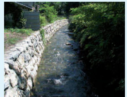
La traversée du Merdaret dans le village, du torrent naturel au torrent canalisé
