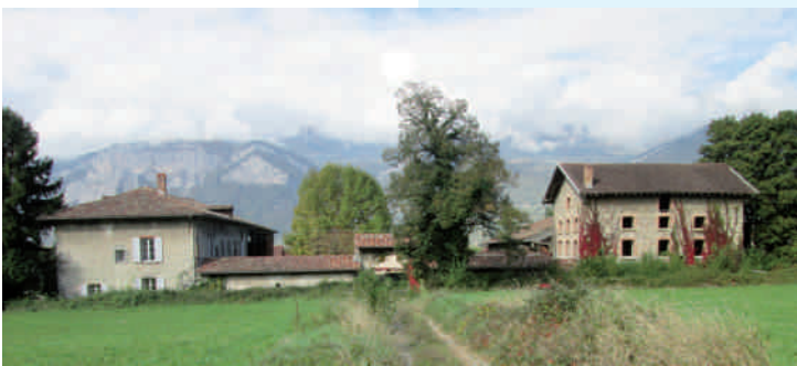
Ancienne ferme du château.
