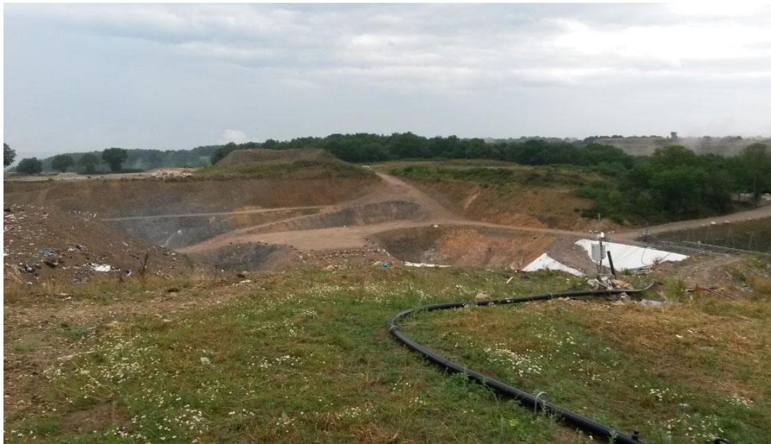
ISDND de Villeneuve, certifié ISO 14001 et 900, particulièrement exemplaire dans le domaine de la valorisation énergétique - SICTOM Région Montluçonnaise
