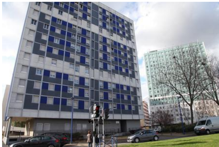
Tour programmée à la démolition dans le quartier de la Verrerie
