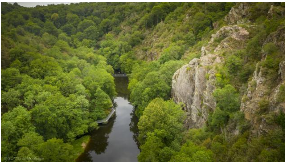
Gorges du Cher, Passerelle à Lignerolles. Source : https://www.valleecoeurdefrance.fr/
