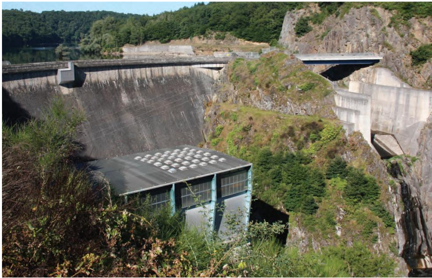
Barrage de Rochebut - DDRM Allier
