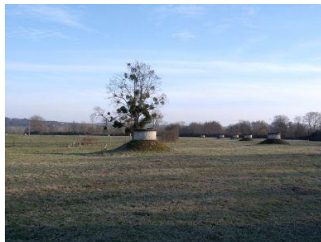
Champ de captage de la Mitte à Reugny - SIVOM Région Minière
