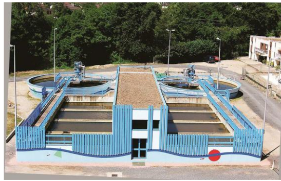
Usine de production d'eau potable de Gour du Puy - SEACAM
