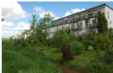
Traitement de l'eau pluviale et aménagement paysager
