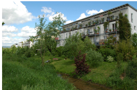
Traitement de l'eau pluviale et aménagement paysager
