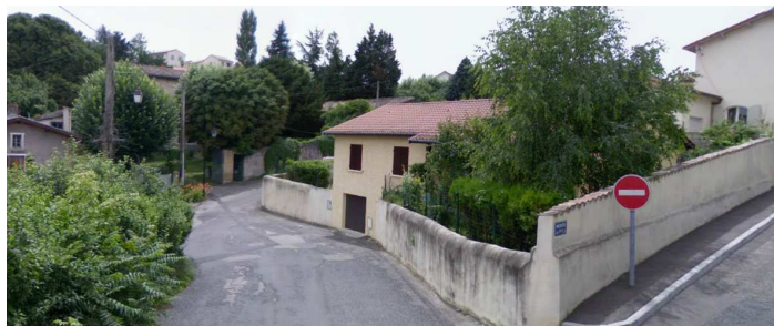
Mur plein, porte cochère, clos et intimité...
