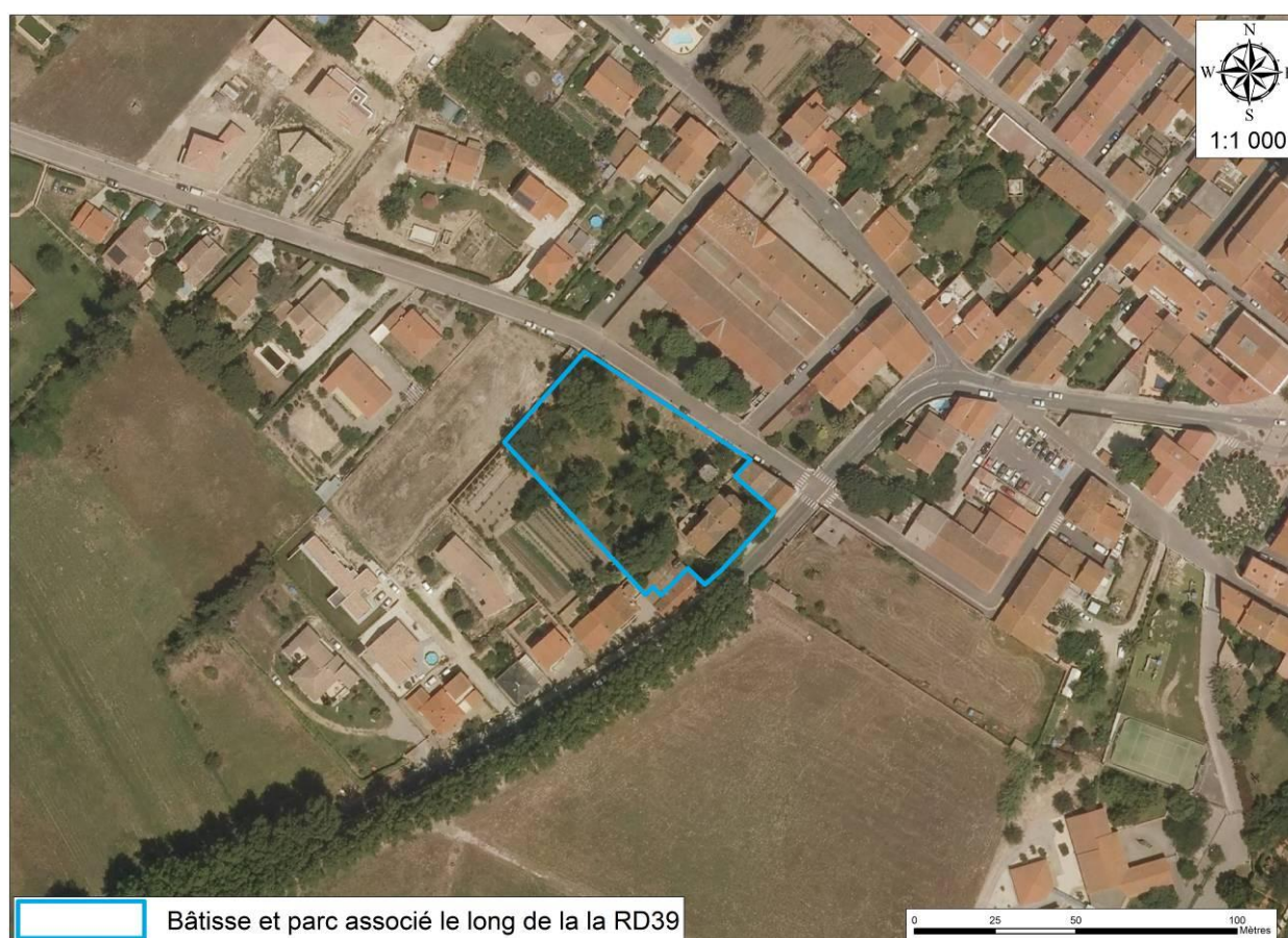
Vue aérienne en 2012 (Nouvelles constructions au Nord-Ouest de la parcelle)
