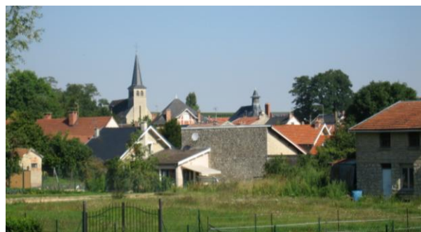
Vue sur l'arrière du bâti
