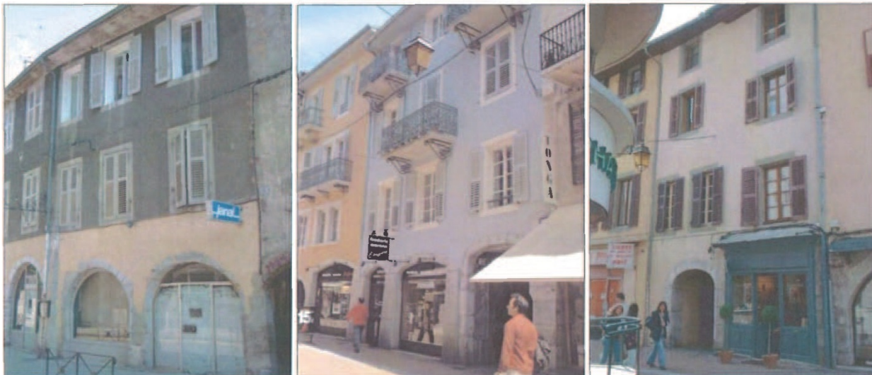
Maisons du 19° siècle sur des vestiges anciens
