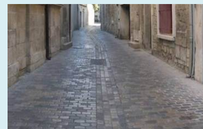
Pavés rejointoyés avec caniveau central
