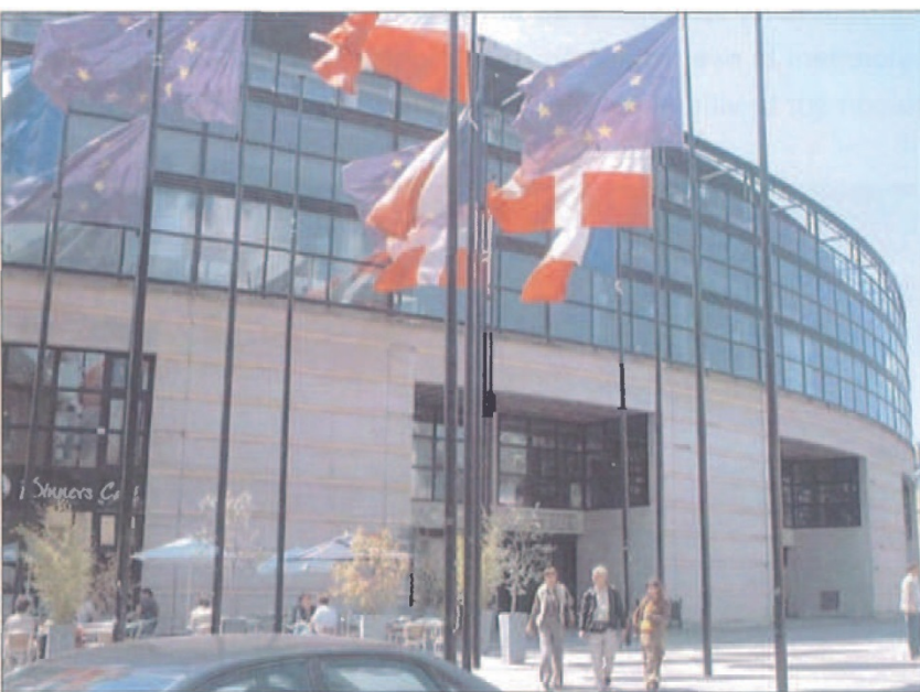
La Médiathèque de Galfetti
