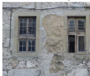
Élément parasite : ventouse de chaudière
