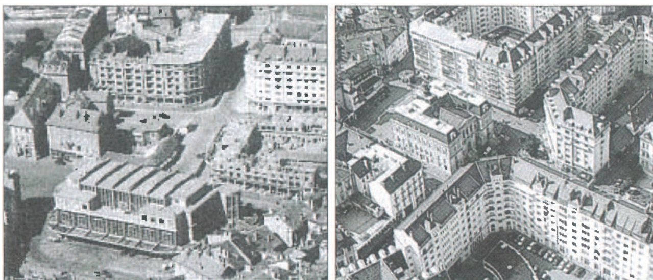
La Reconstruction en cours
