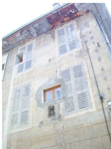
Façade en trompe l'œil (altérée)
