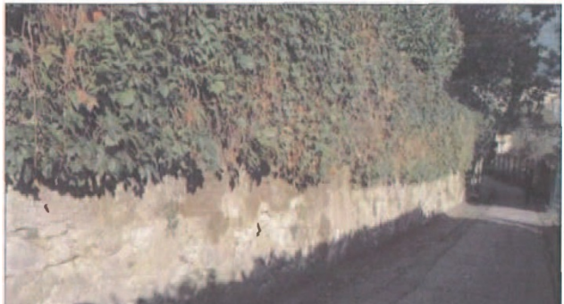
Murs de soubassement en pierre
