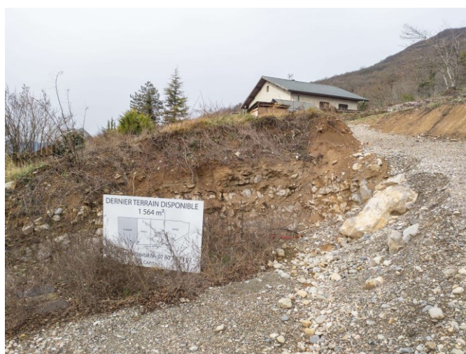
Figure 4 – Déblai à 300m au NE du secteur étudié
