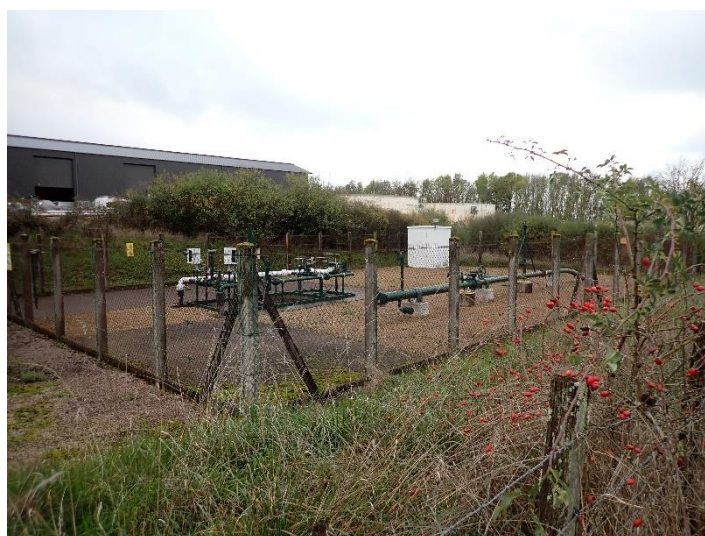
Photo 3 : Zone aménagée au Sud du secteur (in situ - IEA)
