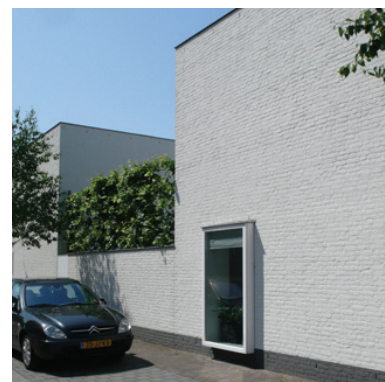
mur en prolongement des constructions
