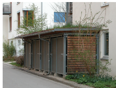
locaux poubelles - quartier Vauban
