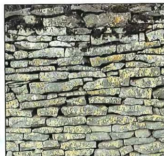
Mur en pierres plates à joints vifs
