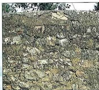
Moellons de granit
