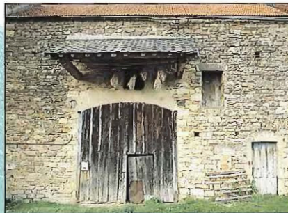
arc segmenté ou arc tendu
