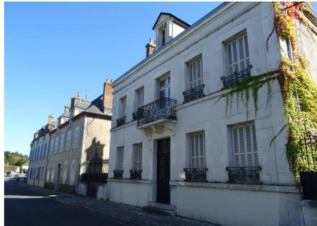
Maison bourgeoise, bandeau de façade, garde-corps ouvragé, corniches et lucarne à fronton
