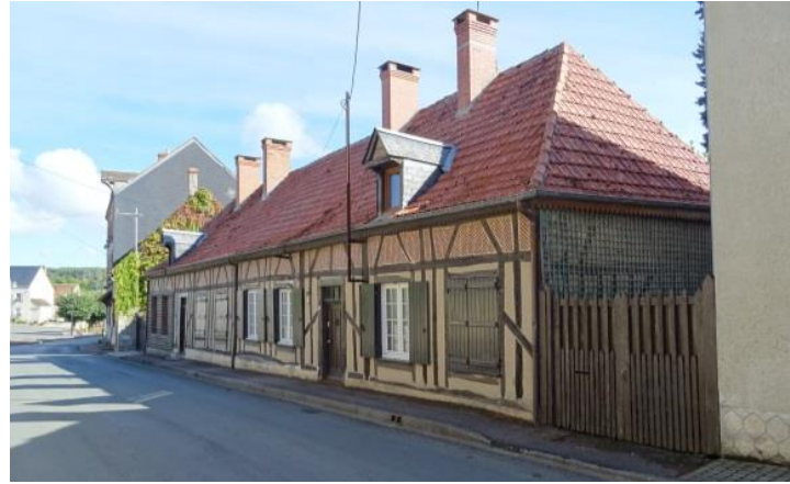
Façade en pierres calcaires, façade en briques, colombage
