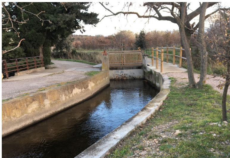
Illustration 15 : Prise de vue de la vanne de contrôle du débit du canal de Perpignan et vanne de décharge rive droite
