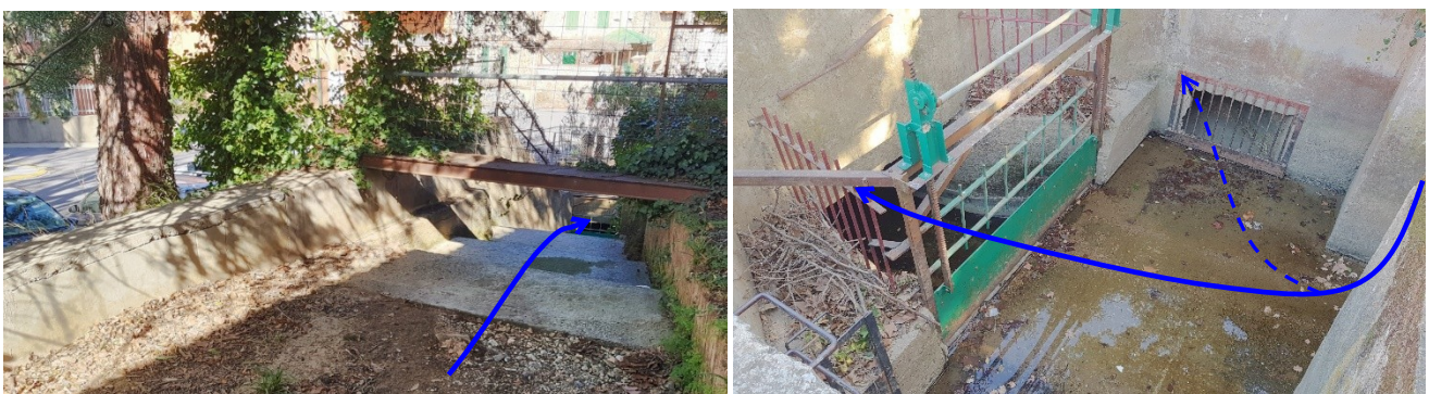
Illustration 21 : Descente du canal de Thuir sous le niveau de la voirie et entrée de la section couverte.
