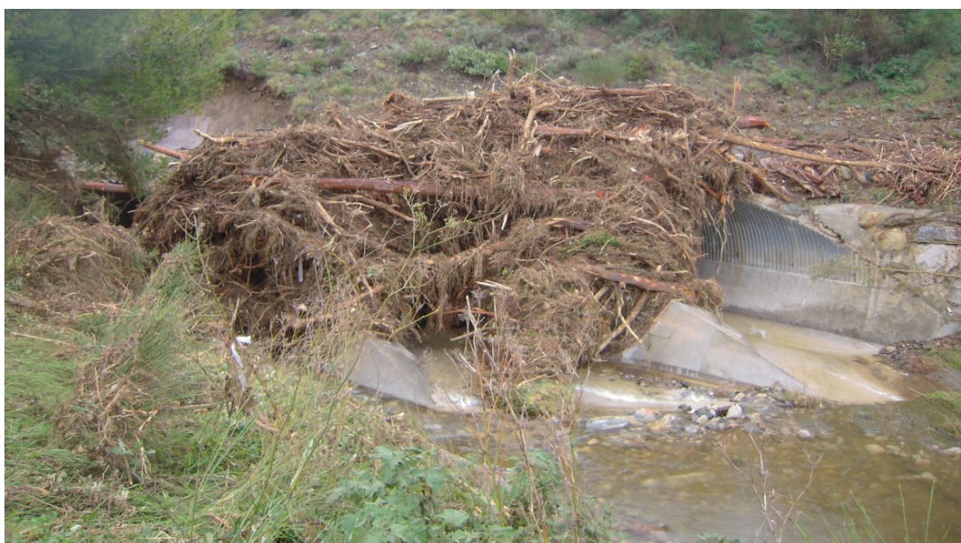
Illustration 9 : Buses sur le ravin Le Ravaner - commune d'Argelès sur mer sous la RD 914 - novembre 2014
