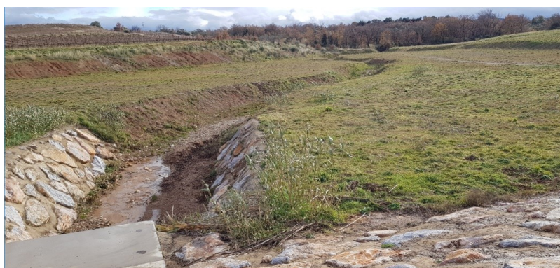
Illustration 20 : Le bassin de Thuir vu depuis la surverse de sécurité
