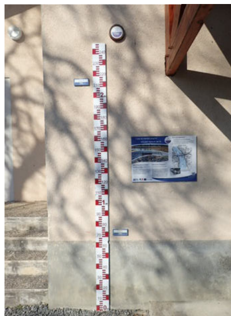
Repère de crue à Châteauneuf du Cher (source : Adev)
