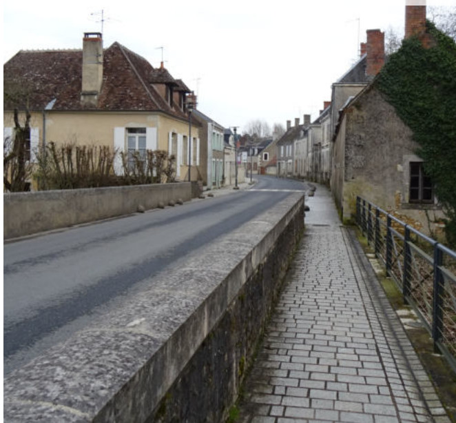
Passerelle piétonnière assurant une traverse sécurisée de l'Arnon à Lignières atopia
