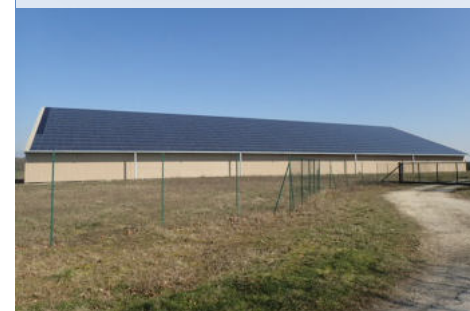
PV en toiture à Levet (source : Adev)
