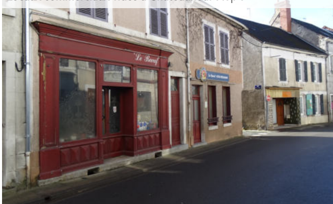
Locaux commerciaux vides à Châteauneuf atopia
