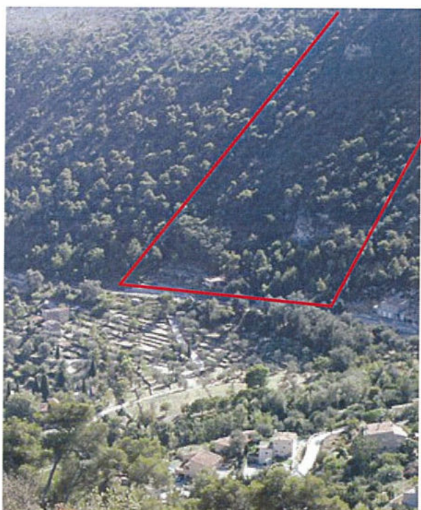
Eboulement d'août 2007 au droit du Bau du Rayet
