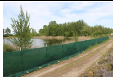
Exemples de filets de protection de la petite faune terrestre mis en place au niveau des clôtures d'un chantier (ATTENTION, il ne s'agit pas ici de dispositifs « à sens unique »)
