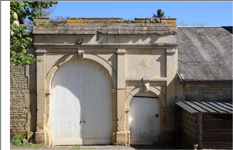
Porche – bâti remarquable Le Marais, parcelle C0243
