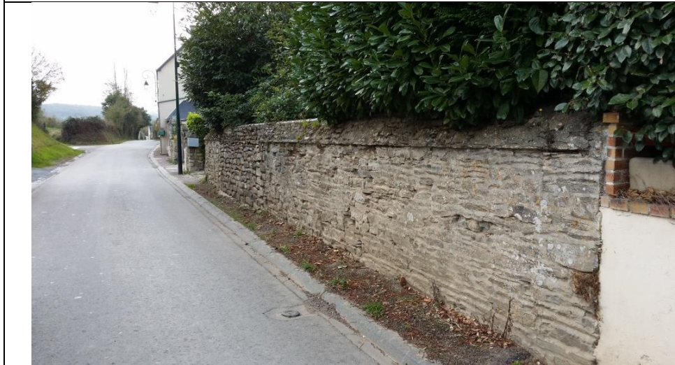
Mur le long de la Voie communale n°2 Le Bourg, parcelles ZD0102-ZD0105-ZD0075
