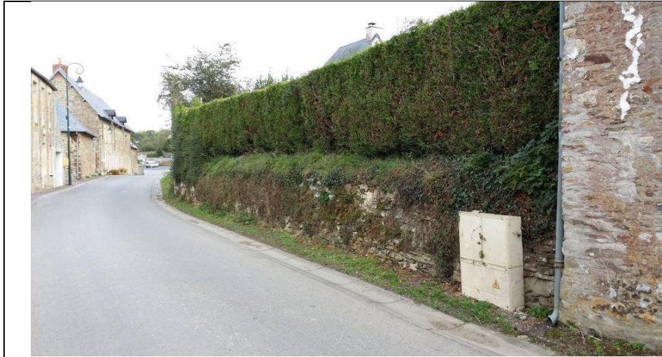
Mur le long de la Voie communale n°2 Le Bourg, parcelles ZC0003-ZC0067
