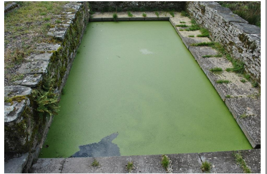
Lavoir – bâti remarquable Épène, non cadastré
