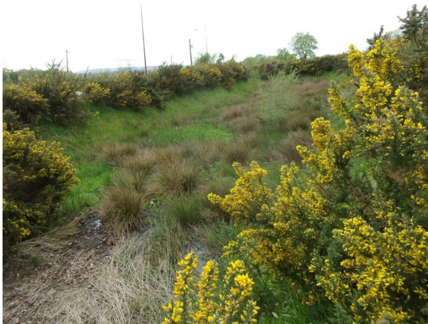
Vue sur un des bassins de rétention des eaux pluviales
