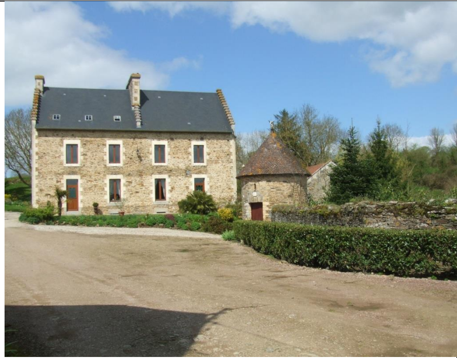
Pigeonnier – bâti remarquable Villodon, parcelle AB0003
