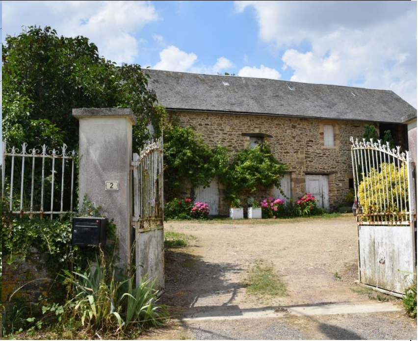
Bâti en pierre 2 route du Bourg, parcelle ZD0030
