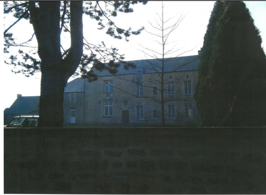
Manoir – bâti remarquable Le Manoir, parcelle B0185
