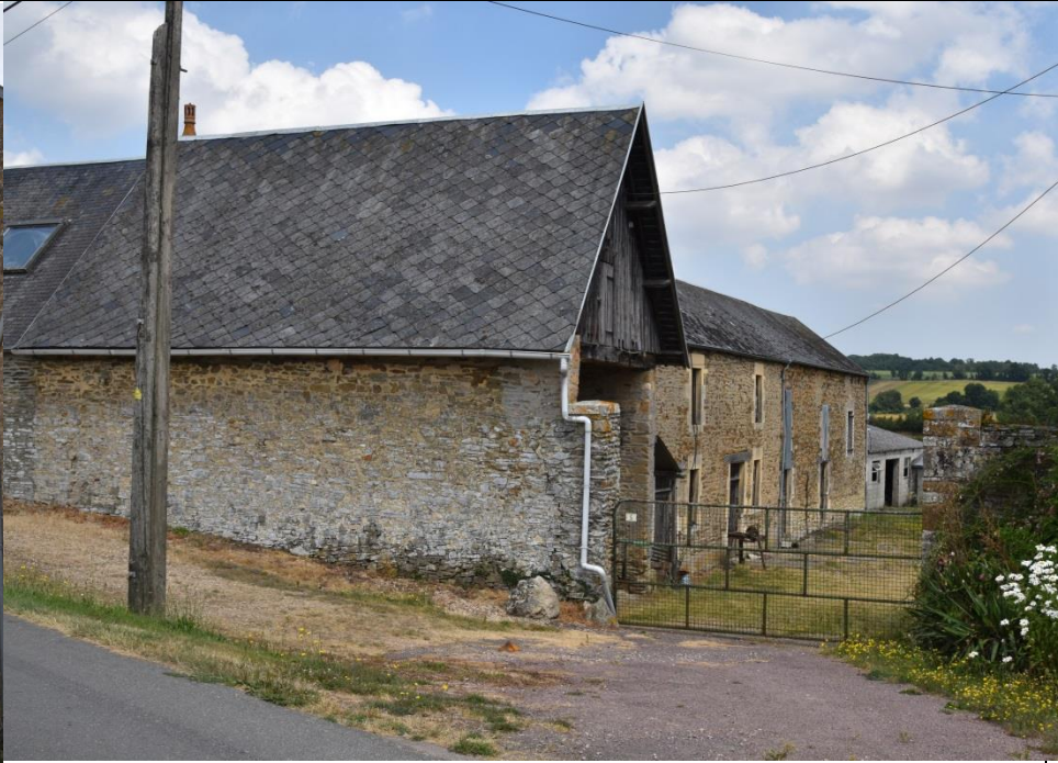
Bâti en pierre 5 route du Bourg, parcelle B0192
