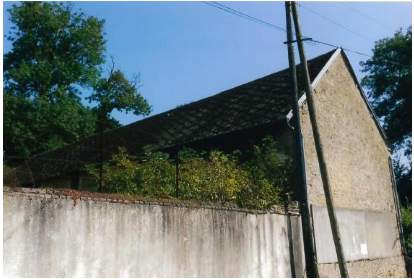
Ferme du Vieux Château L'Église, parcelle A0081
