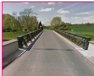
7- Pont du canal de St-Quentin
