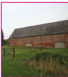
3- Hangar en briques
