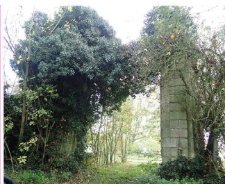
4- Vestiges d'une porte
