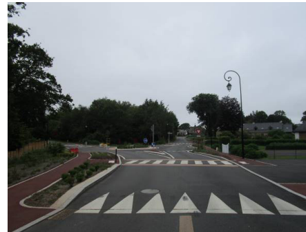
ENTRÉE DE VILLE EST AMÉNAGÉE ET SÉCURISÉE
