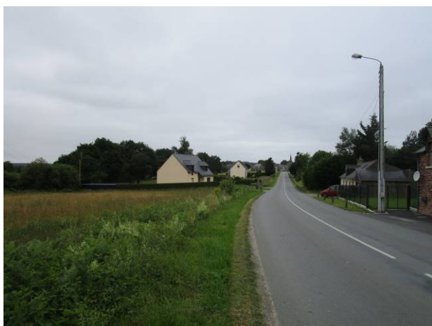
ENTRÉE DE BOURG OUEST BANALISÉE ET NON SÉCURISÉE
