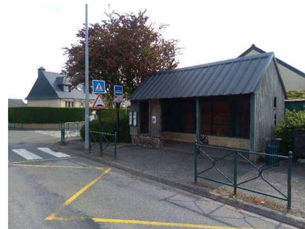
BRÉAL-SOUS-MONTFORT – ARRÊT DE CAR – RUE DES ECOLES
