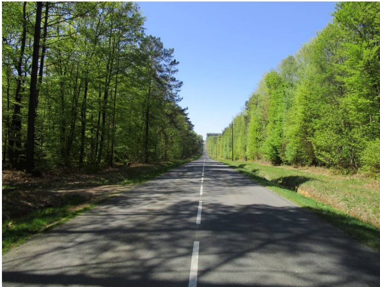
TRAVERSÉ DE LA FORÊT SUR LA RD 40 :
